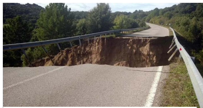
Figura 1: Il crollo del terrapieno sulla provinciale 38 Olbia-Tempio in cui sono morte 3 persone (18 Novembre 2013)
