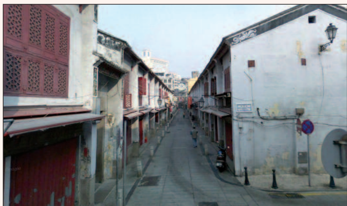
Figura 2 - Una strada del centro di Macao: Rua da Felicidade
