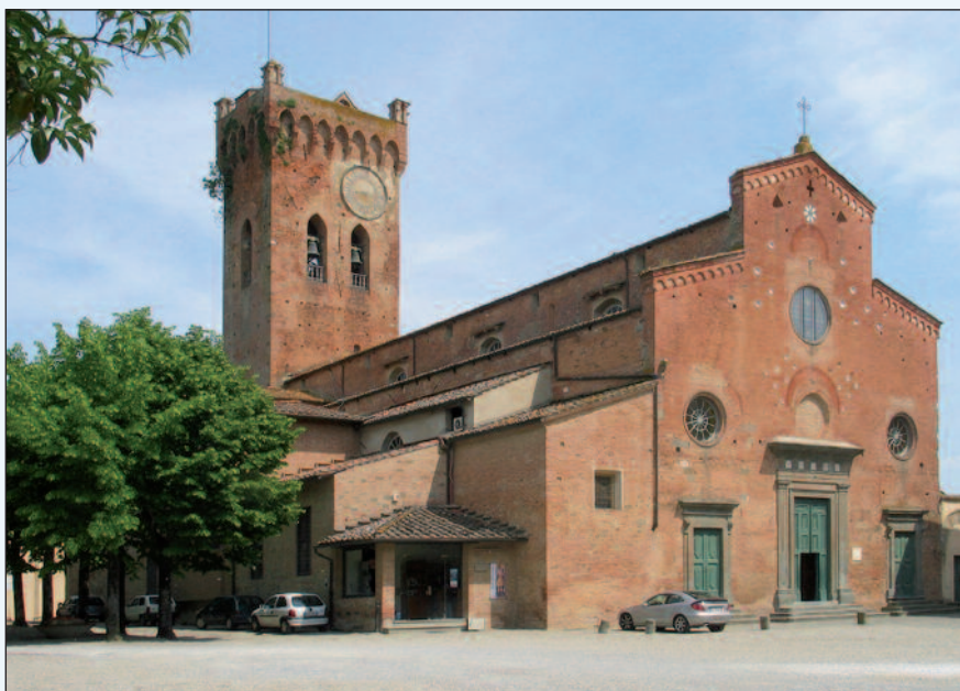
A San Miniato, la Torre di Matilde e la chiesa medievale edificata su una preesistente dell'VIII secolo
