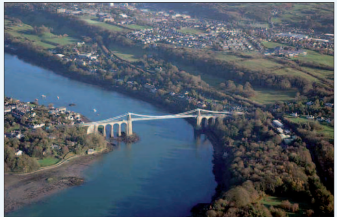
Vista dall'alto del ponte Britannia sullo stretto di Menai
