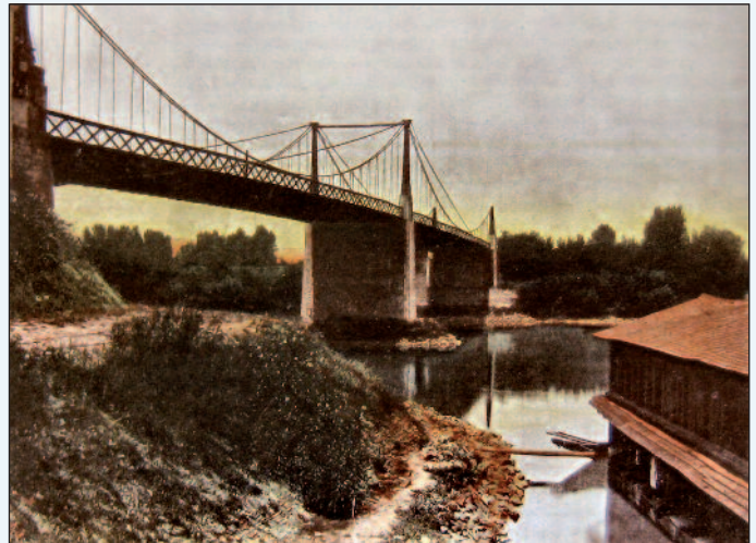
Il ponte di Chalonnes sulla Loira
