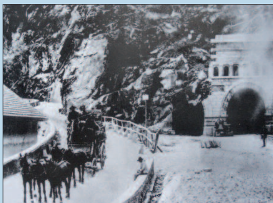
La via del Sempione: a destra l'imbocco della galleria ferroviaria in costruzione
