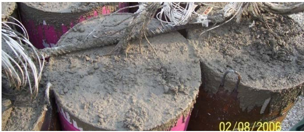
Figura 3: Fase di getto dei colonne presso il cantiere del nuovo ospedale di Bergamo
