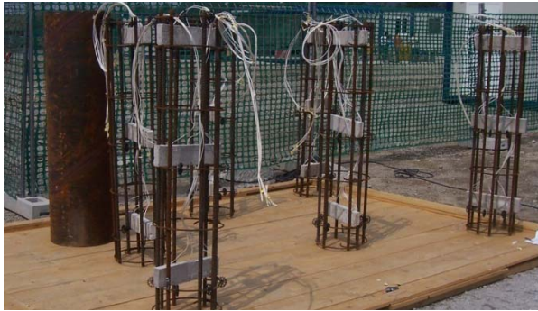
Figura 2: Posizionamento termocoppie presso il cantiere del nuovo ospedale di Bergamo
