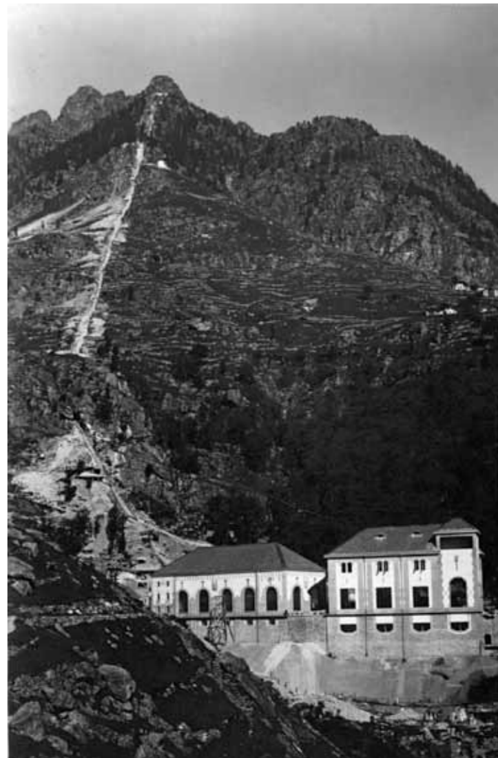
Impianto Truzzo-San Bernardo: diga del lago Truzzo; la centrale di San Bernardo, 1927-1928 (Archivio Nucleo idroelettrico Edipower di Mese)
