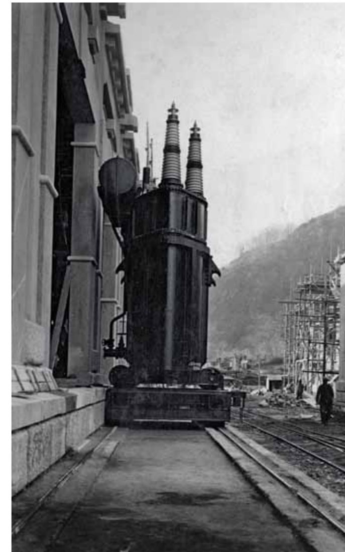
Impianto del Liro inferiore: trasformatore davanti alla cabina elettrica di Mese (Archivio Nucleo idroelettrico Edipower di Mese)
