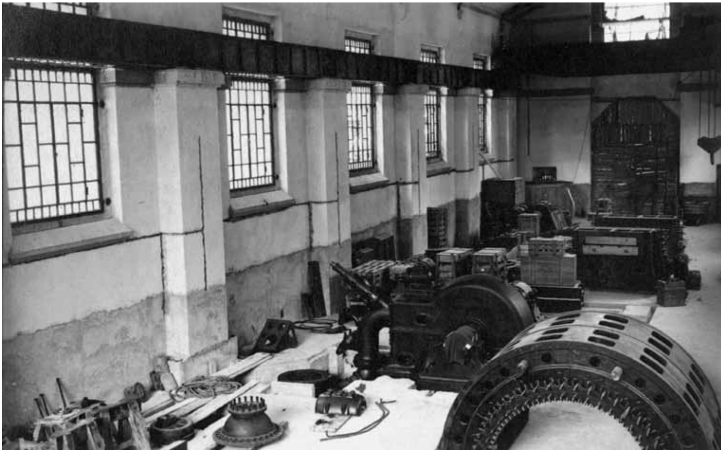
La sala macchine della centrale di Mese, 1926 (Archivio Nucleo idroelettrico Edipower di Mese)
