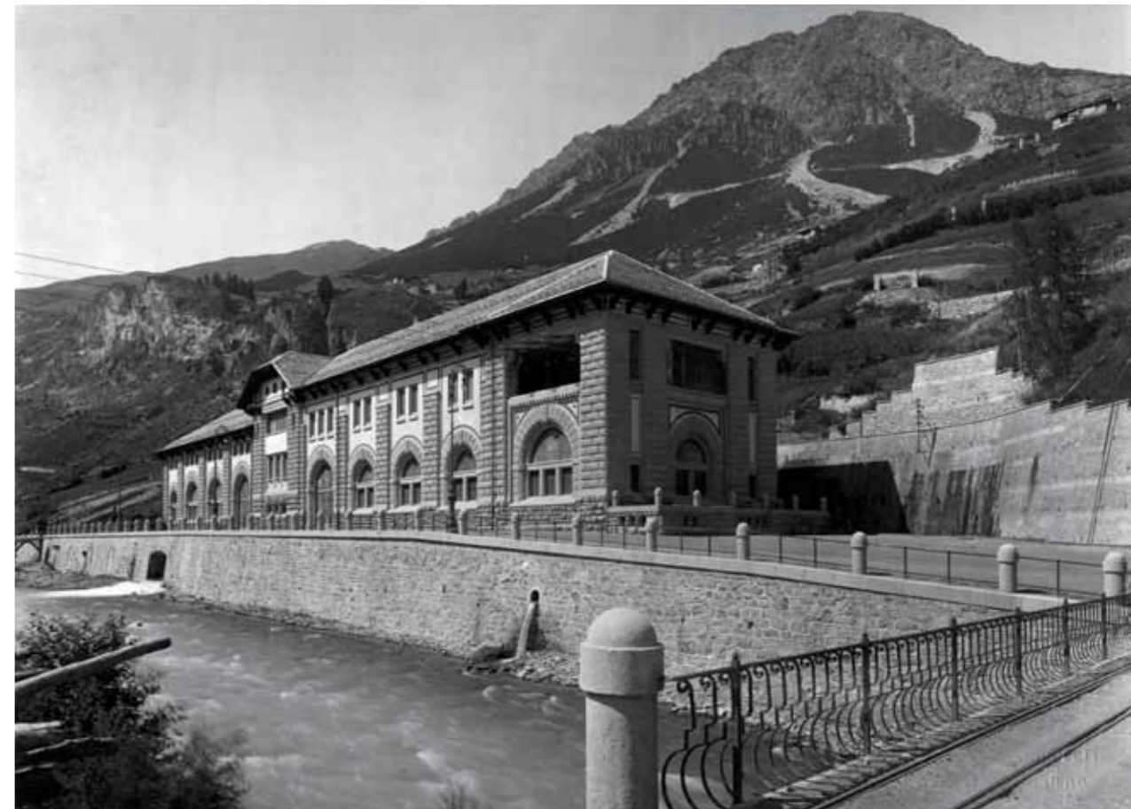
Impianto Fraele-Viola: GIULIO PALENI, centrale di Isolaccia, 1926-1928 (foto A. Paoletti, Archivio fotografico Fondazione AEM)
