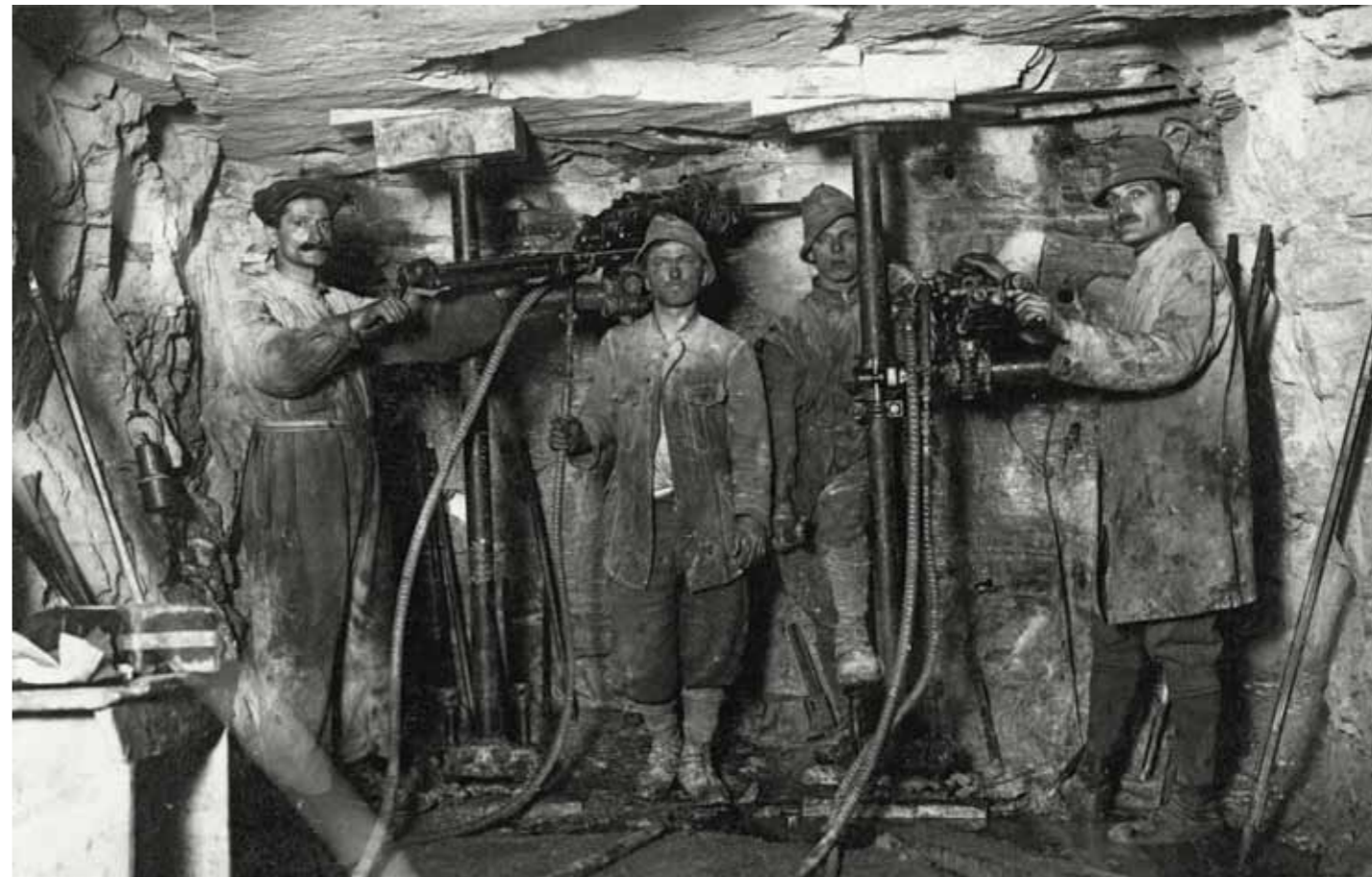
Lavori di scavo della galleria Prestone-Olmo: minatori con perforatrici Ingersoll, 1923 (Archivio Nucleo idroelettrico Edipower di Mese)
