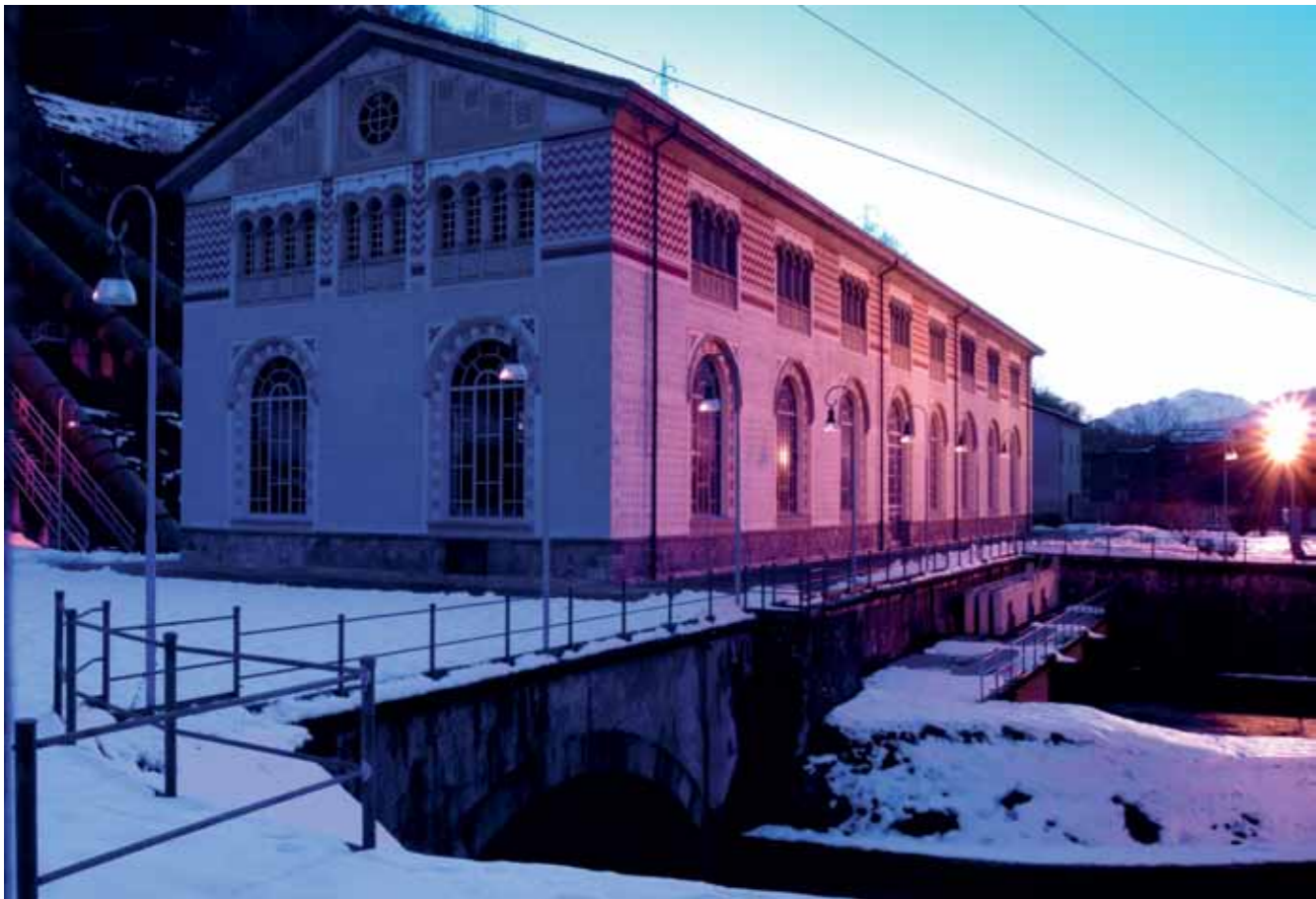
CARLO MINA, centrale di Boffetto, 1917-1918 (foto di G. Menini, gennaio 2013)
