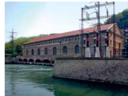
La centrale A. Bertini di Paderno d'Adda, attivata dall'Edison del 1898
