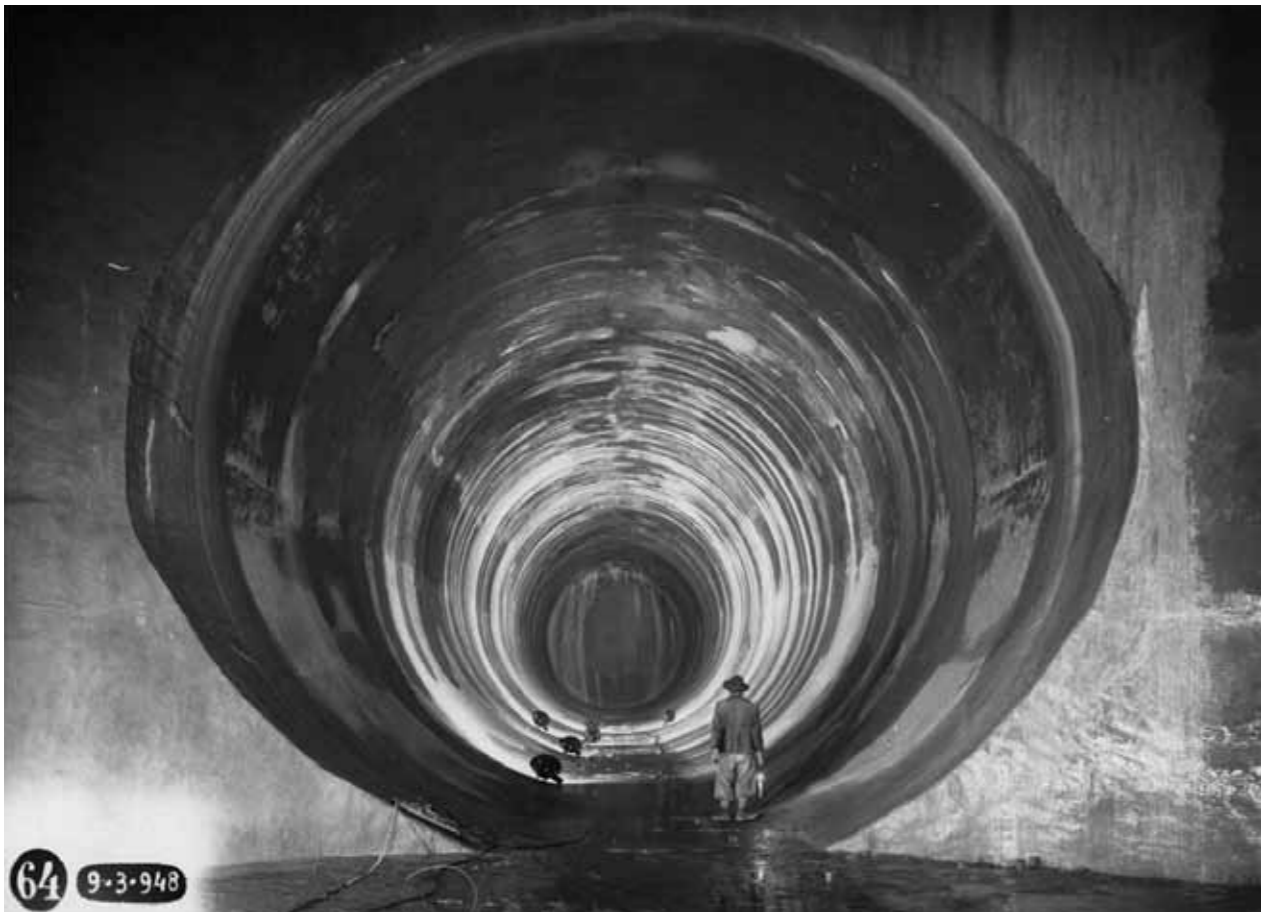
Lavori di costruzione della galleria in pressione dalle vasche di presa, centrale di Lovero (foto di G. Chiolini, 1949, Archivio fotografico Fondazione AEM)
