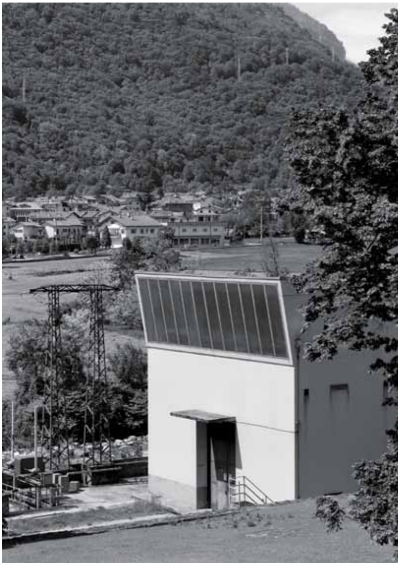
Impianti del Mera II e III salto: GIO PONTI, centrale di Prata Camportaccio, 1950-1951; GIO PONTI, centrale di Gordona, 1950-1951 (foto di Václav Šedý)
