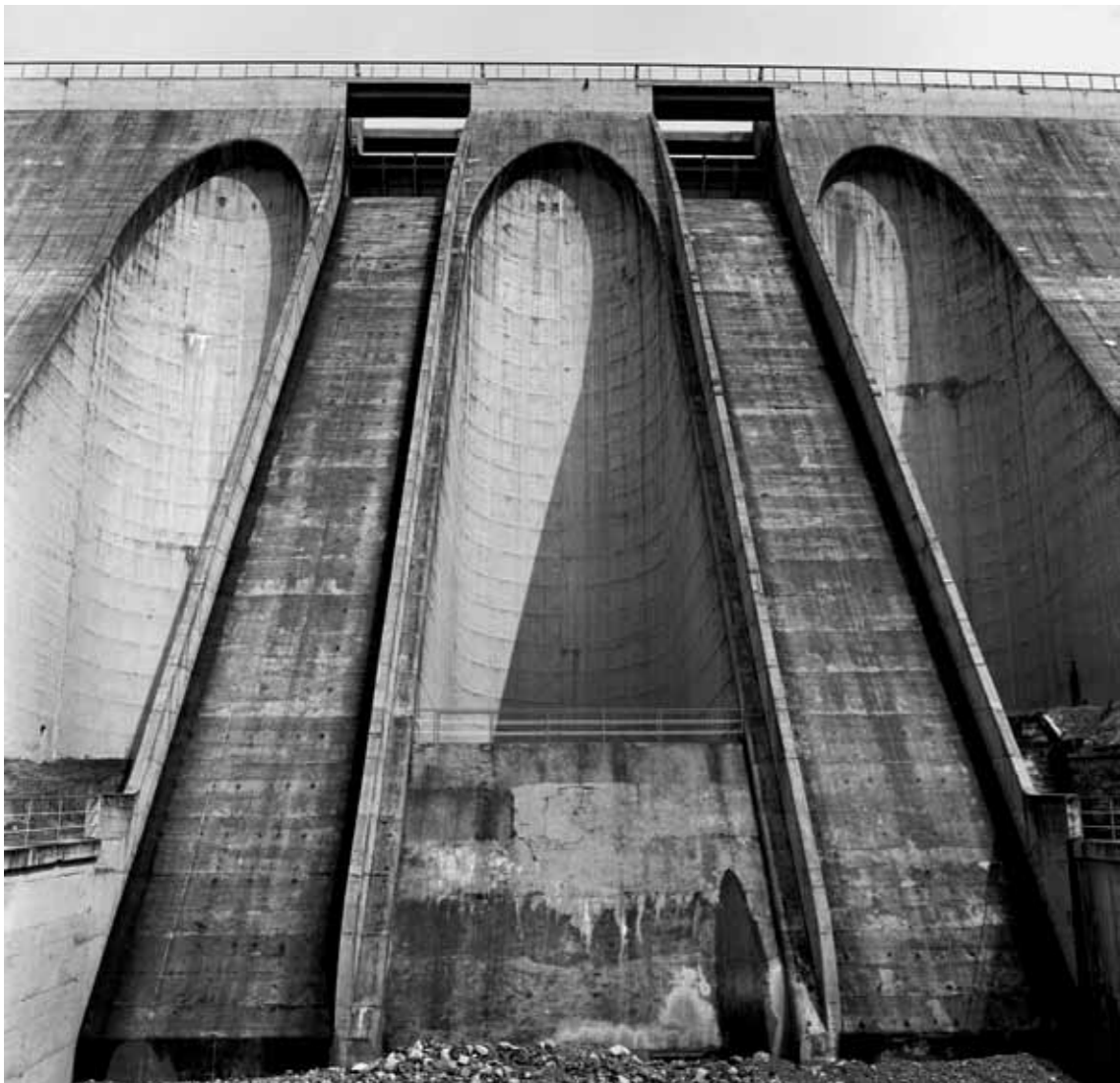
Impianto di Grosio: gli sfioratori della diga della val Grosina (Archivio fotografico Fondazione AEM)
