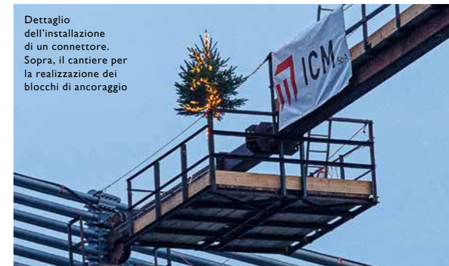
I 24 cavi di sospensione del ponte (12 per lato) messi in opera da un macchinario trascinato da una funicolare
