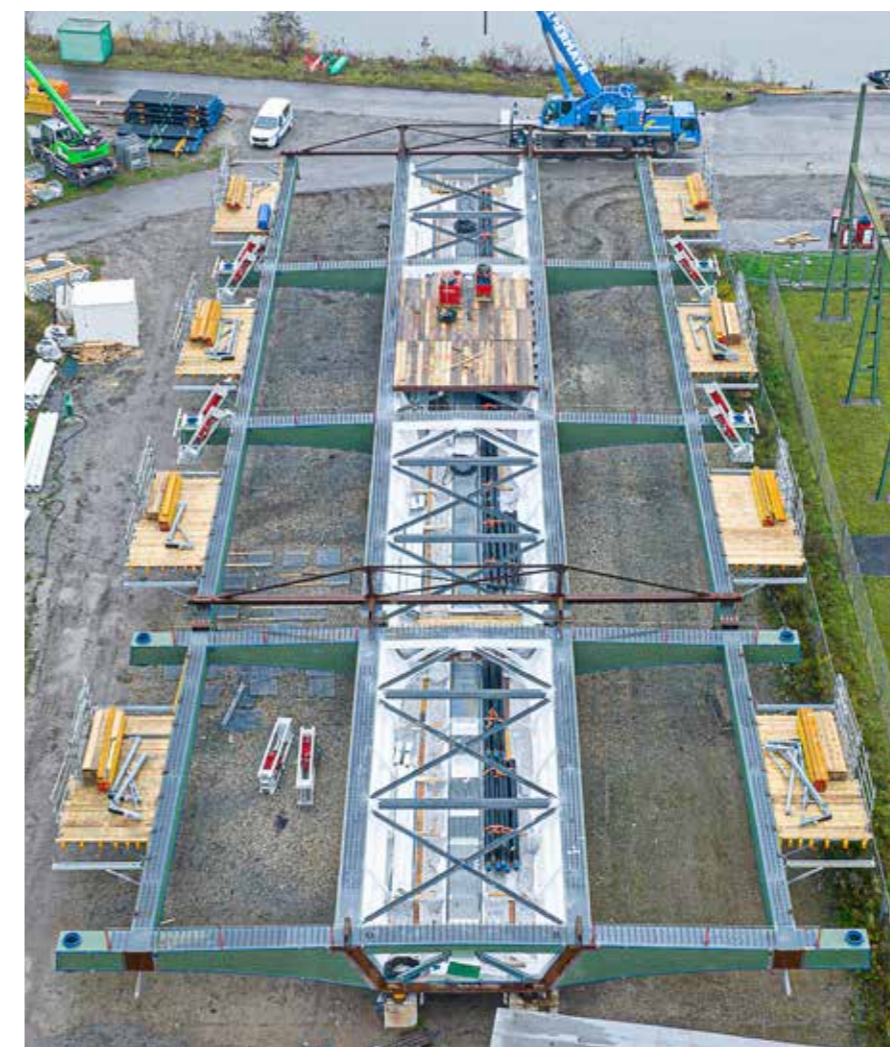
Dettaglio tecnico di un macroconco del ponte. Sotto, pre-assemblaggio dei macroconci del ponte, accatastati in un'apposita area collocata lungo il fiume, a una distanza di circa 20 km dal cantiere
