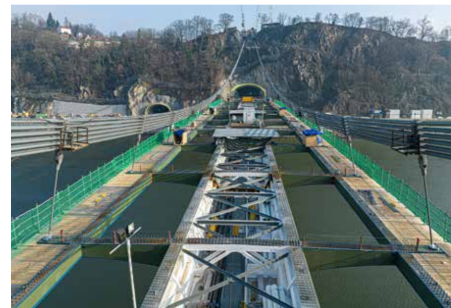
Giuntura degli 8 macroconci del ponte. Sopra, realizzazione della soletta del ponte
