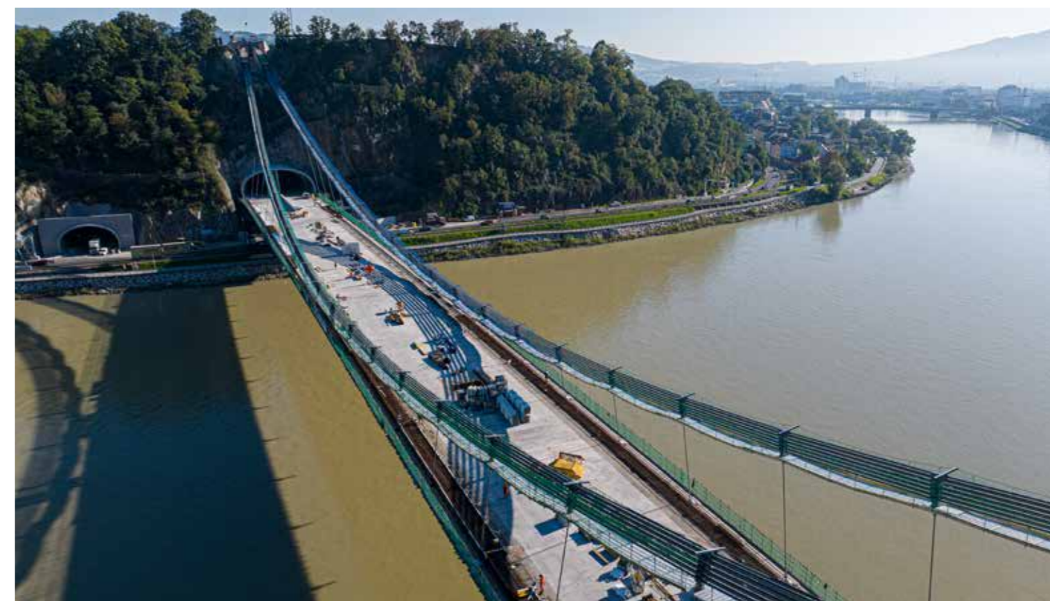
Giuntura degli 8 macroconci del ponte. Sopra, realizzazione della soletta del ponte
