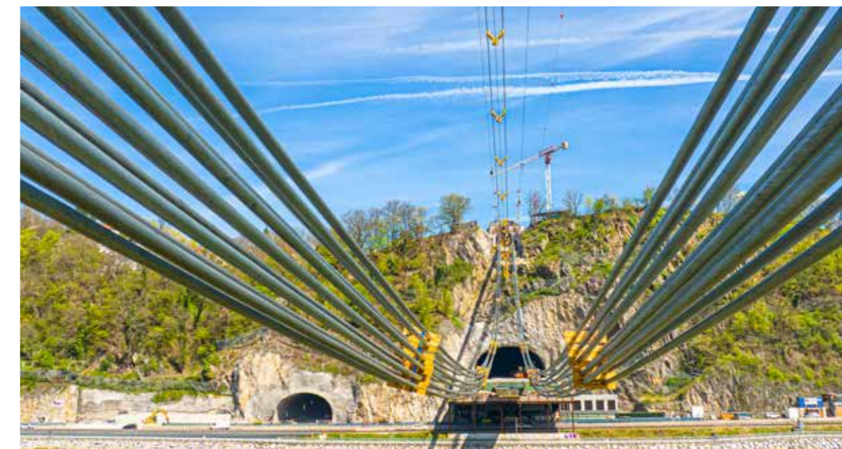
I 24 cavi di sospensione del ponte (12 per lato) messi in opera da un macchinario trascinato da una funicolare
