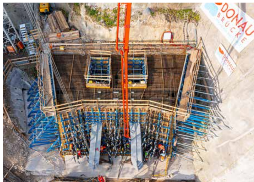
Realizzazione dei blocchi di ancoraggio
