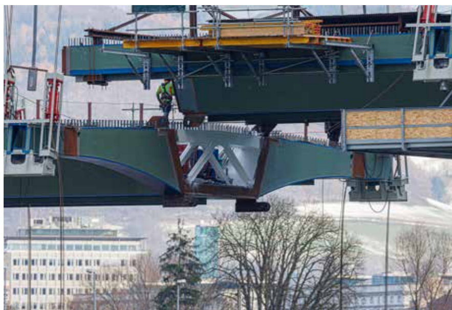
Aggancio di due macroconci del ponte che sono stati sollevati dalla chiatte e messi in posizione
