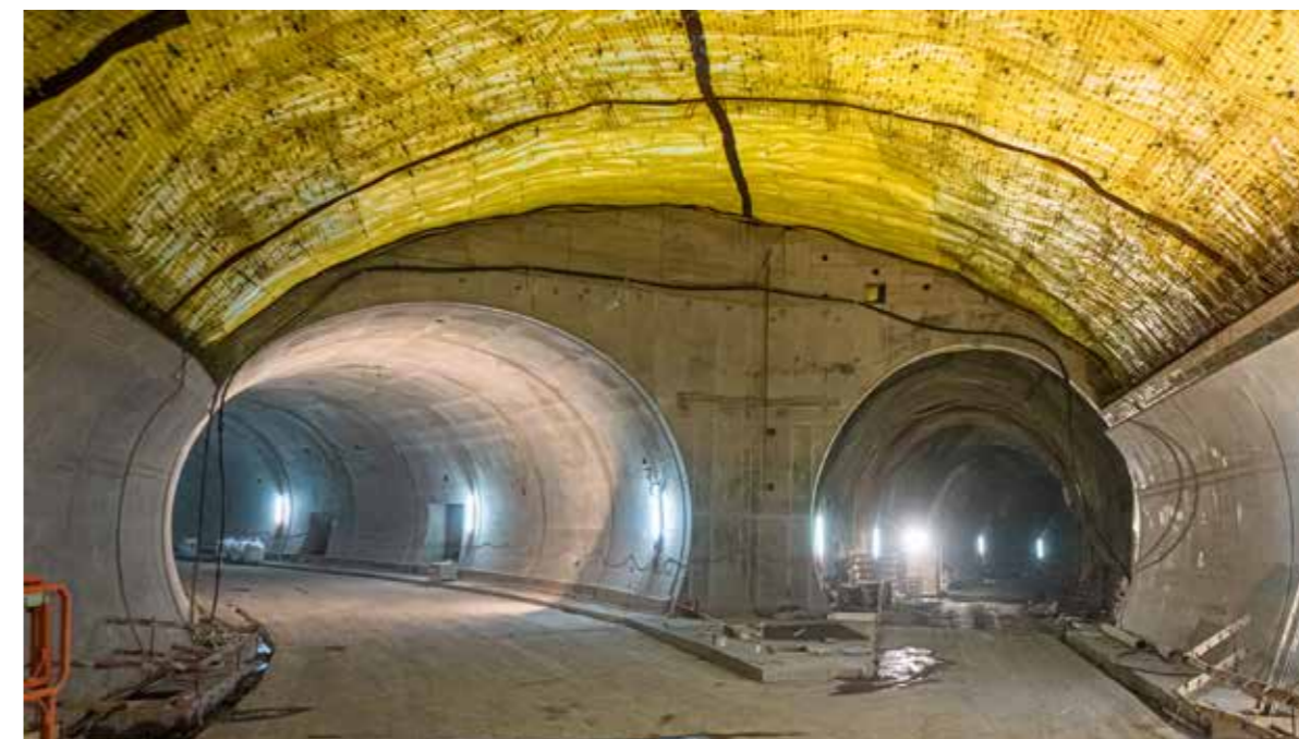
Messa in opera del rivestimento definitivo del tunnel, realizzato con un getto di calcestruzzo all'interno di casseri mobili
