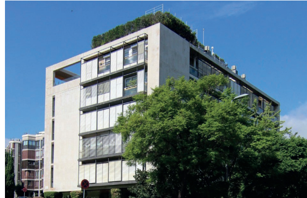
Fig. 7. F. Mitjans. House in Avenida Tokyo (Source: M. Lucchini, 2019).
