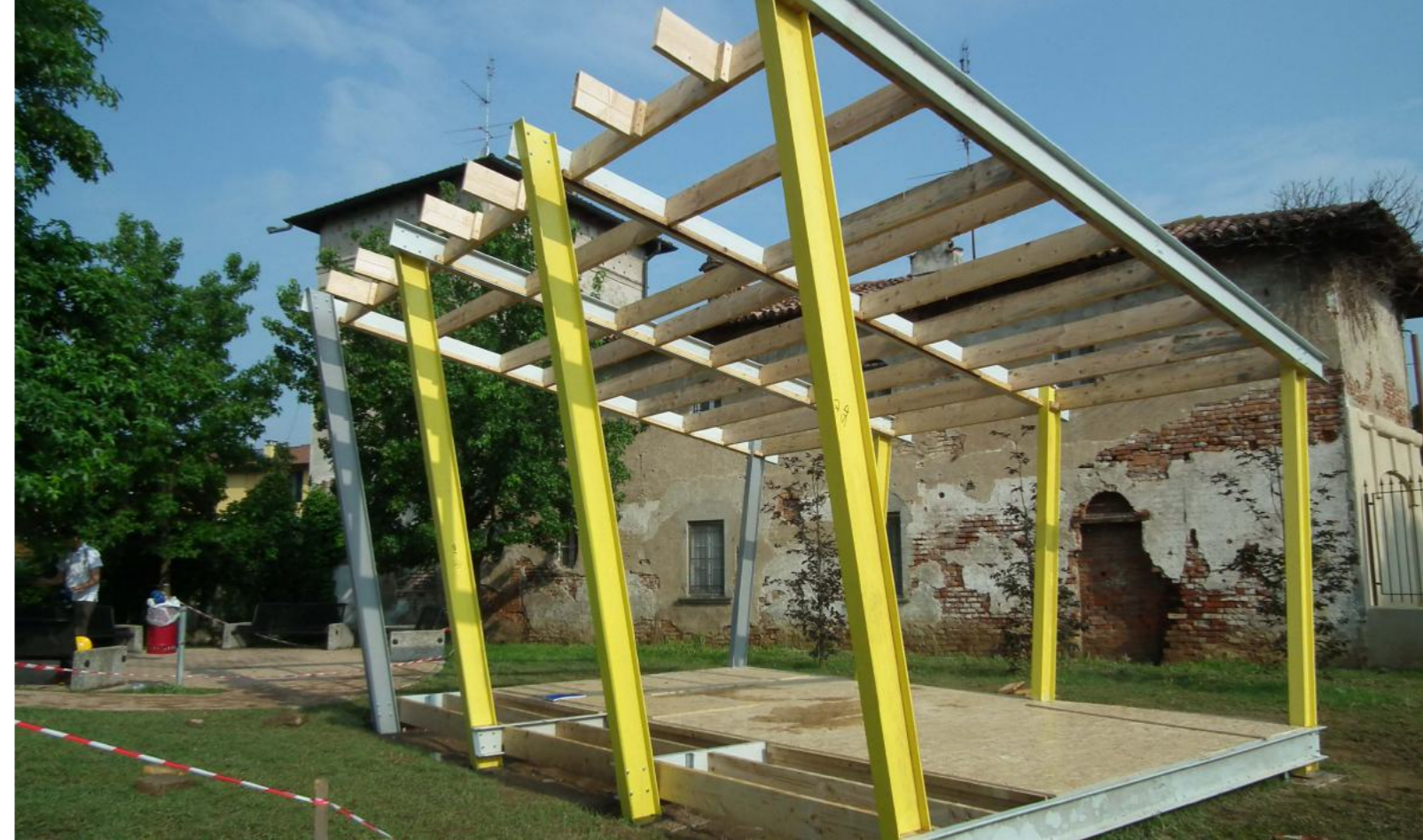
Fig. 2 Modulo Stone 2 realizzato ad Abbiategrasso nel 2014 dagli studenti del Laboratorio di Costruzione 1 della Scuola di Architettura del Politecnico di Milano - prof. A. Rogora e prof. M. Fianchini. Il modulo è realizzato utilizzando un sistema Segal modificato che utilizza elementi strutturali di recupero in fibra di vetro accoppiati ad elementi in legno.
