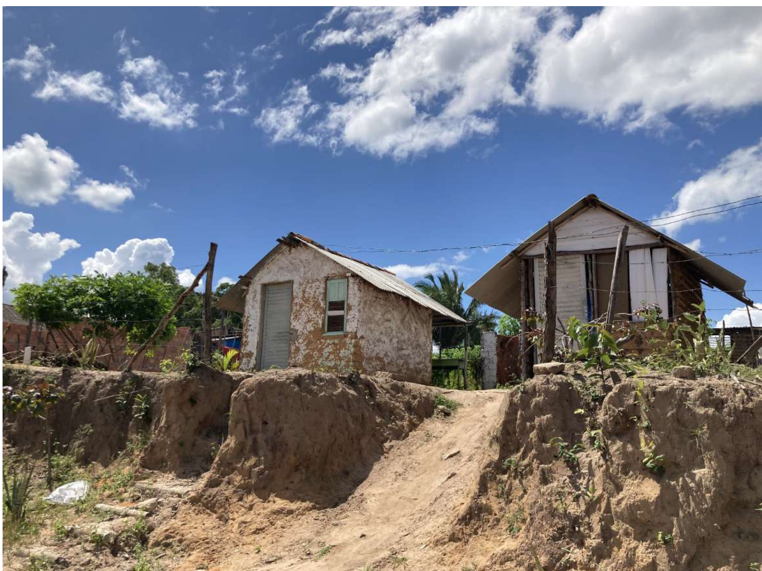
3b. Casas feitas de terra o materiais residuais, ao longo da rua que delimita o conjunbto habitacional planejado | Self-built mud house or built with waste materials, along the street bordering the planned neighbourhood | Case autocostruite in terra o materiali di scarto, lungo la strada di confine del quartiere pianificato | photo: M. Mareggi
