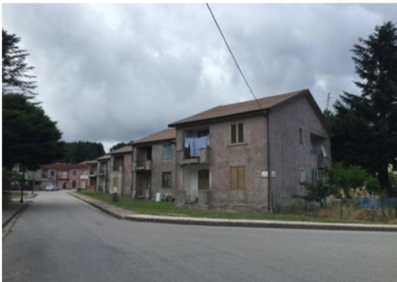
Figures 11-12. Canolo Nuova, Reggio Calabria (photos N. Sulfaro, 2022)
