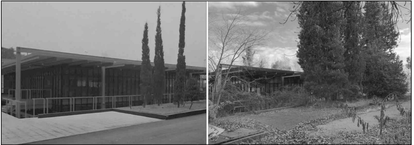
Figure 3 - Building M designed for the canteen and locker rooms before and after decay (picture on the left source: "MOLLIFICIO BRESCIANO, Mollificio Bresciano / [progetto grafico e redazione Studio Del Lago; fotografie di Gabriele Basilico], San Felice del Benaco, Mollificio Bresciano, 1988, p. 27").
