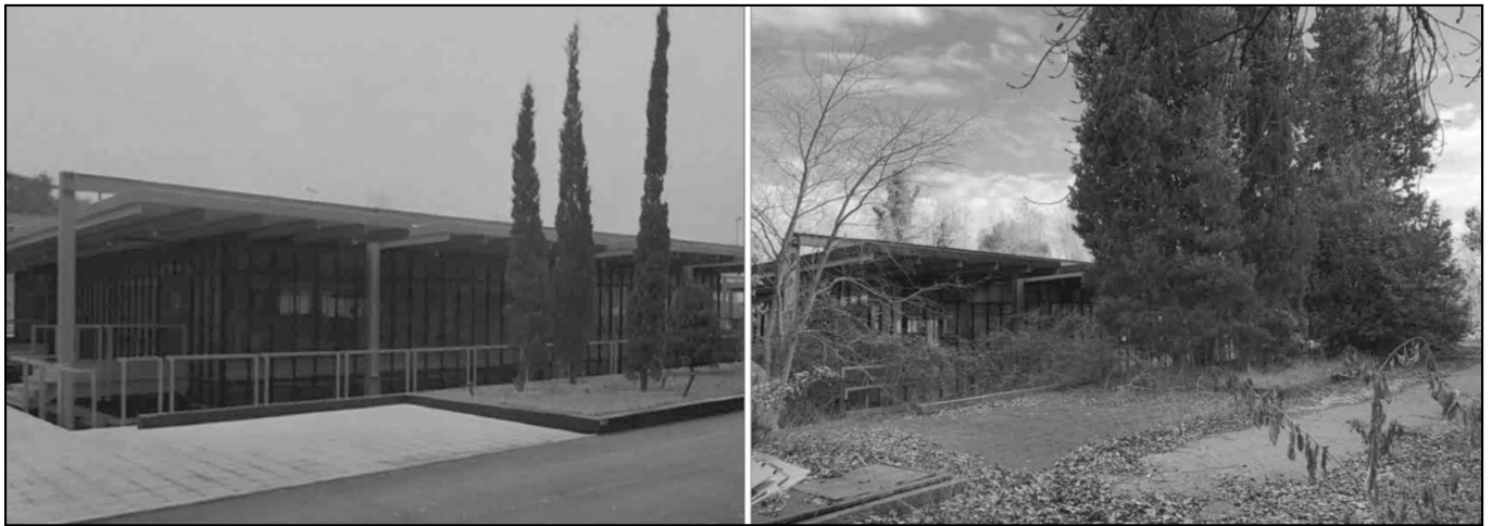
Figura 3 - Edificio M destinato alla mensa e agli spogliatoi ante e post degrado. (fotografia a sinistra fonte: "MOLLIFICIO BRESCIANO, Mollificio Bresciano / [progetto grafico e redazione Studio Del Lago; fotografie di Gabriele Basilico], San Felice del Benaco, Mollificio Bresciano, 1988, p. 27").
