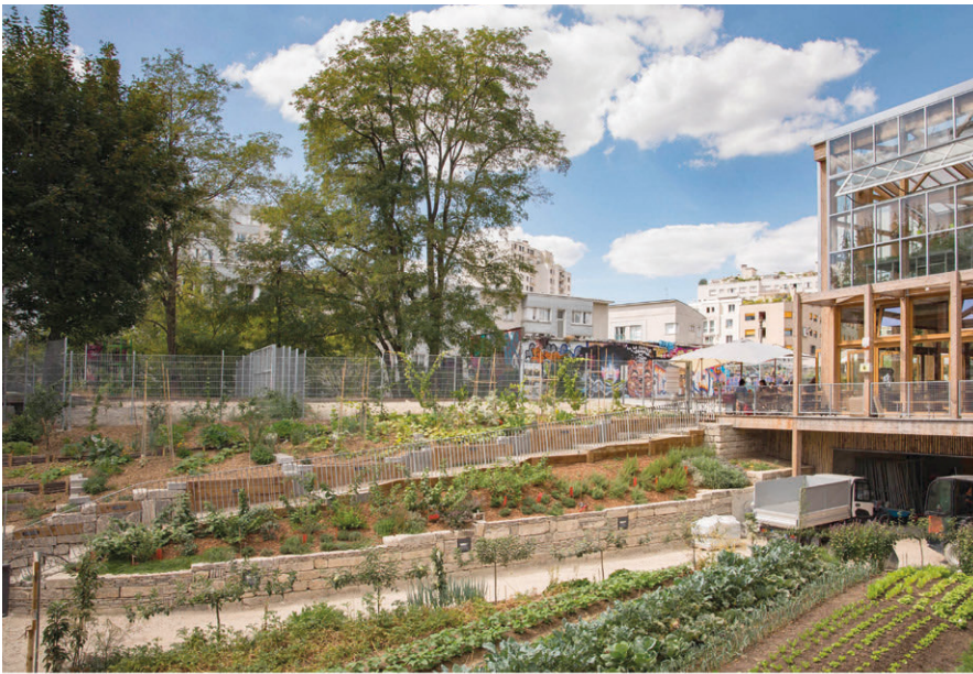
06. Ferme du Rail, Fotografia della realizzazione | Ferme du Rail, Picture of the realization. paris.fr
