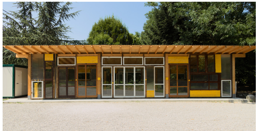
Fig. 1 - Casa Chiaravalle, Milano / Casa Chiaravalle, Milan (Source: ARCÒ).
