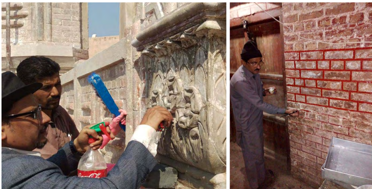
Fig. 3. Pakistan, Multan Walled City. A sinistra: Haram Gate, prove di pulitura. A destra: Musafir Khana, "rifacimenti" decorativi dei giunti (foto degli autori, 2018).
