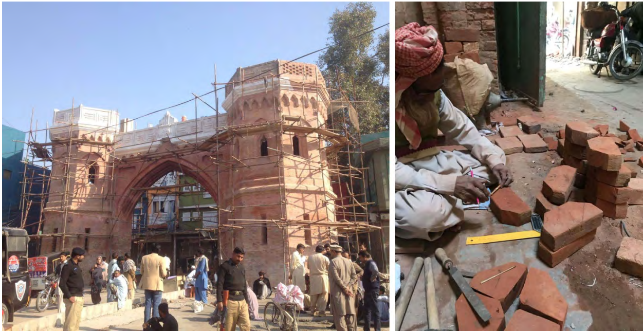
Fig. 2. Pakistan, Multan Walled City, Haram Gate. La ridipintura in bianco della cornice della porta (a sinistra). A destra: Musafir Khana, la preparazione dei pezzi per i rifacimenti e le integrazioni (foto degli autori, 2018).
