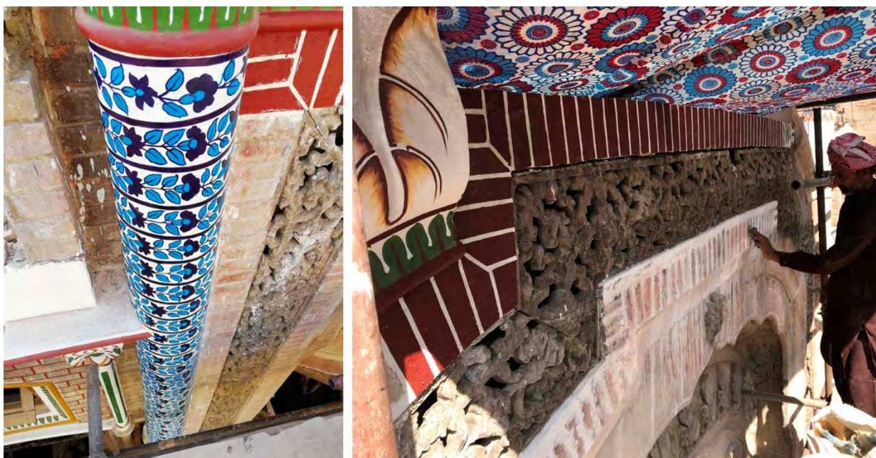
Fig. 1. Pakistan, Multan Walled City, Musafir Khana. Lavori di rifacimento degli apparati decorativi (foto degli autori, 2018)
