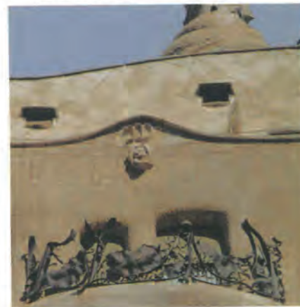
Casa Milá, particolare dell'apparato decorativo Casa Milá, detail of the decoration
