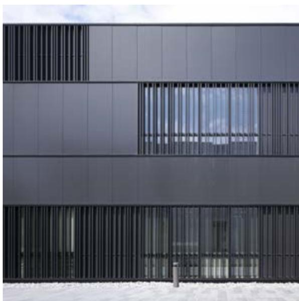
**Tessitura della cortina del corpo destinato a magazzino, rivestito dalle superfici modulari in lamiera stratificata e racchiuso dalle sezioni vetrate sulle quali si dispongono i filari frangisole verticali in alluminio**
