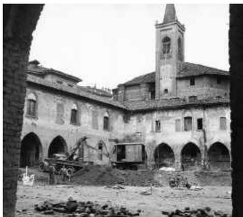
FIG. 17 - Chiostro, vista interna verso la chiesa, durante il cantiere per l'abbassamento della quota di calpestio
