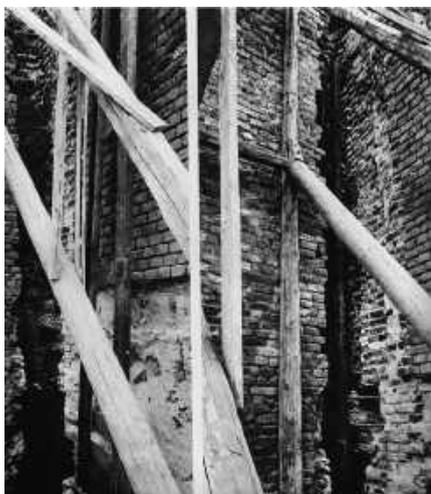
FIG. 8 - Puntellature in legno a sostegno della muratura
