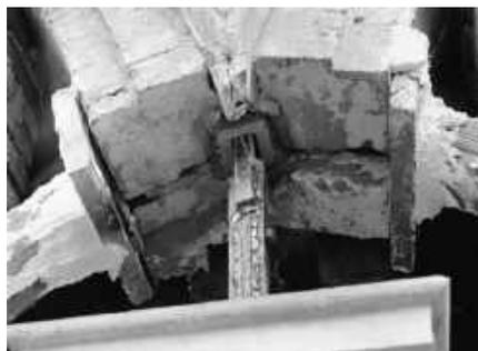
FIG. 10 - Centina archi, struttura di sostegno
