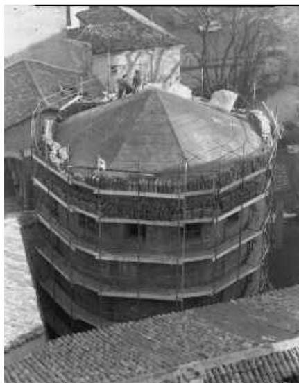
FIG. 5 - Copertura, durante il rifacimento
