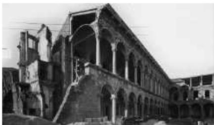
FIG. 10 - Cortile centrale, fase avanzata del cantiere (ricomposizione per anastilosi dei portici)
