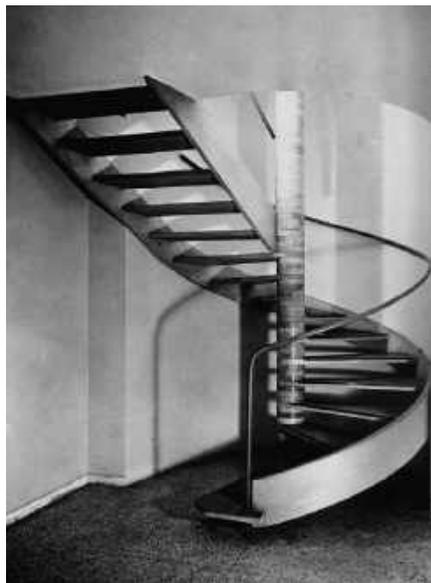
FIG. 1 - Scala elicoidale in legno
