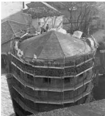
FIG. 5 - Copertura, durante il rifacimento
