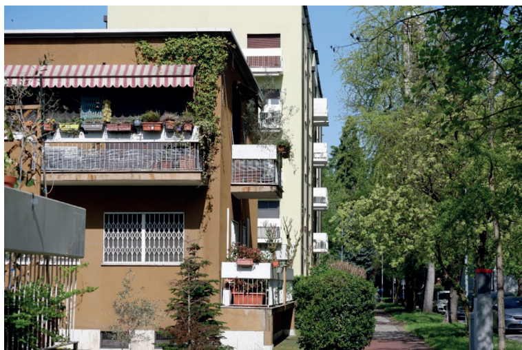
Figura 8. Il patrimonio abitativo a Metanopoli (Foto: Constanze Wolfgring).
