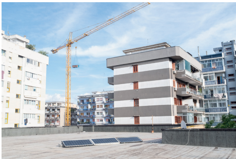
Figura 7. Il terrazzo dell'ex Socrate. Alcuni residenti-occupanti hanno realizzato dei piccoli impianti fotovoltaici per sopperire alla mancanza di energia elettrica. ©Savino Carbone/2025
