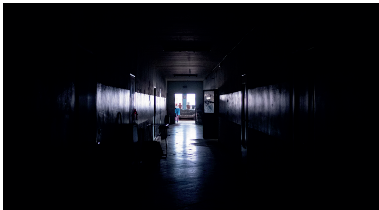
Figura 4. Uno dei corridoi superiori dell'ex liceo Socrate al buio perché sprovvisto di energia elettrica. ©Savino Carbone/2025
