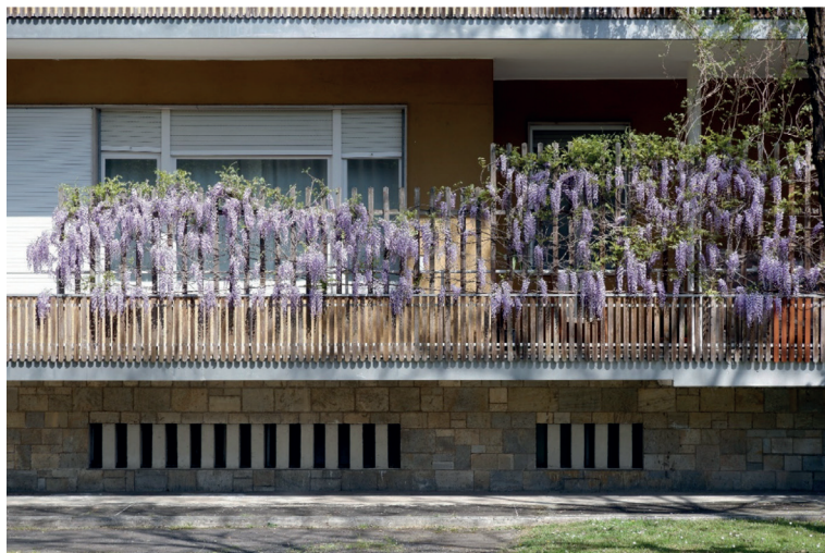
Figura 7. Il patrimonio abitativo a Metanopoli (Foto: Constanze Wolfgring).
