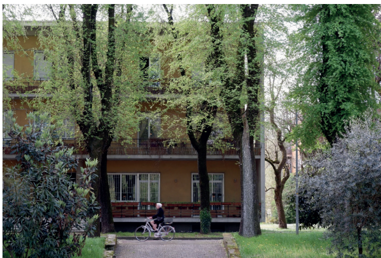
Figura 6. Il patrimonio abitativo a Metanopoli (Foto: Constanze Wolfgring).
