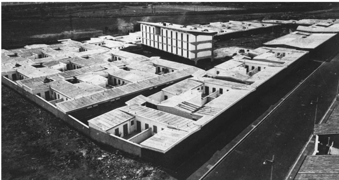
Veduta dell'Unità d'abitazione orizzontale nel quartiere Tuscolano a Roma, arch. Adalberto Libera, 1950-1954
