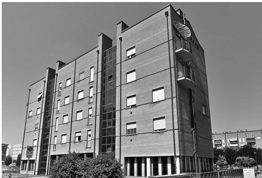
Fig. 4: Contratto di Quartiere I – Comune di Piacenza 'San Giuseppe Baia del Re'. Vista lato strada, via Alfredo Sbolli (fonte: Google Maps)
