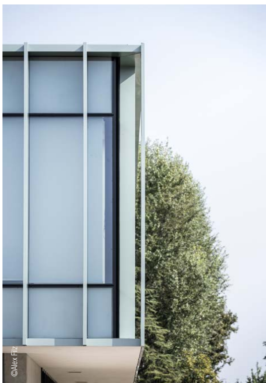
Espressione morfologica degli apparati strutturali di telaio avvolti dalle sezioni di rivestimento esterno
