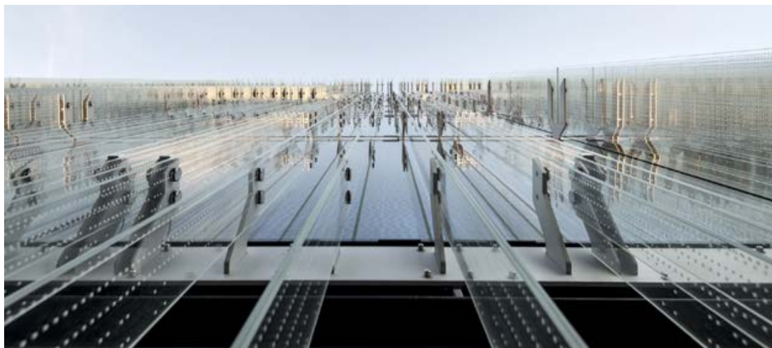
Metodologia di composizione costruttiva dei supporti alle "pinne" esterne, della doppia chiusura vetrata e della cavità di intercapedine
