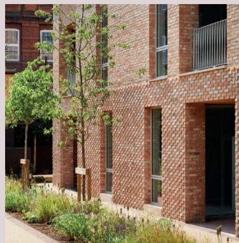
Scorcio dell'attacco a terra. © Jack Hobhouse
