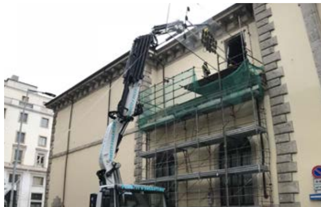
Fase di sollevamento e di inserimento della lastra di vetro entro il vano di ingresso
