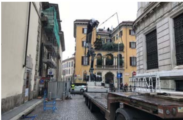
Fase di fissaggio della lastra di vetro per il sollevamento al vano di ingresso
