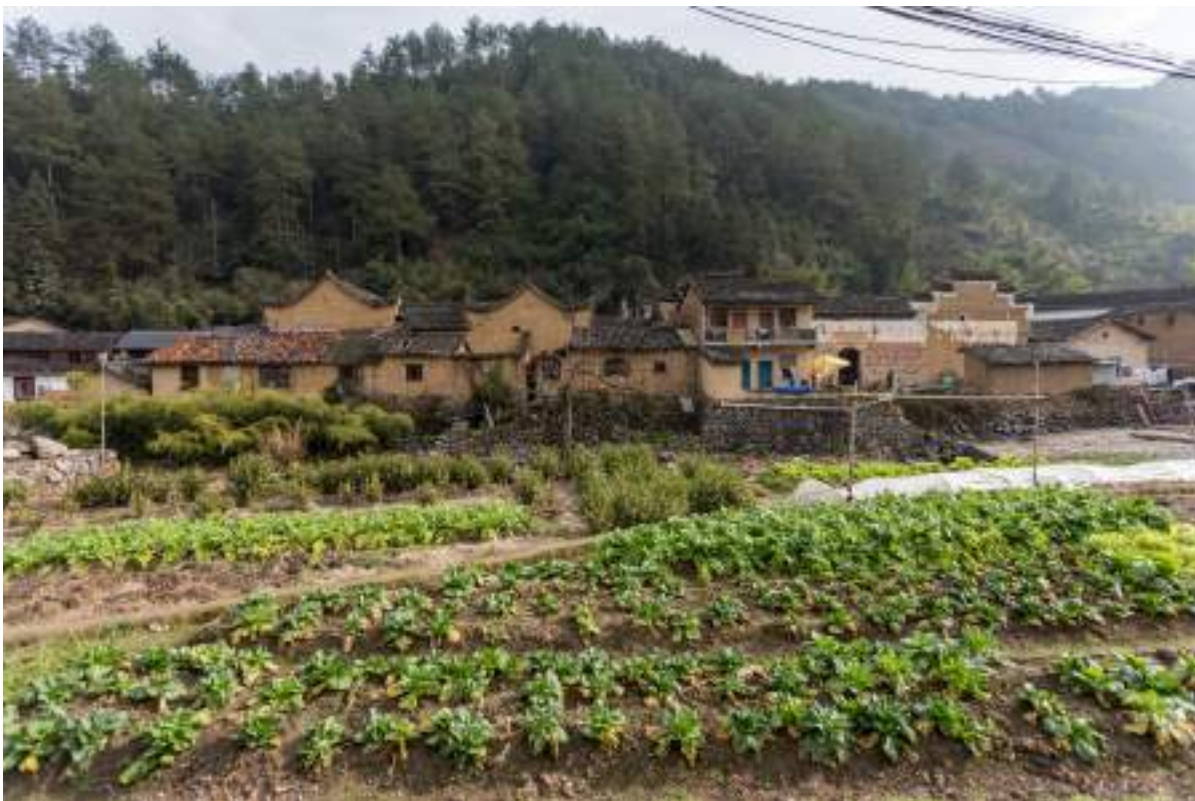
Fig. 10. Provincia del Zhejiang, residenze vernacolari in stato di progressiva decomposizione, gennaio 2018 (foto dell'autore).
