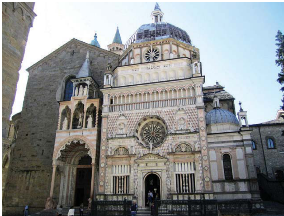
Fig. 1/ Basilica di Santa Maria Maggiore, Bergamo. Lato settentrionale della navata
