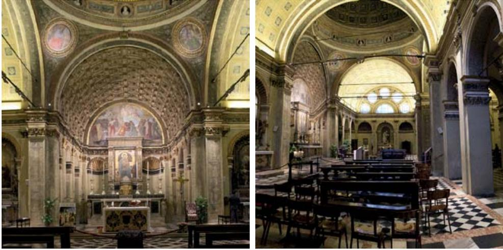
Fig. 4/ Vista assiale e laterale del finto coro prospettico in legno e stucco che simula un braccio del transetto.
