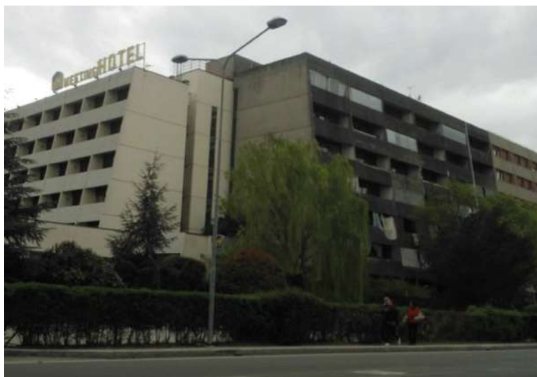
Fig. 7 – Vista del corpo Ovest prima della demolizione. Fonte: Associazione Architetti di Strada.
