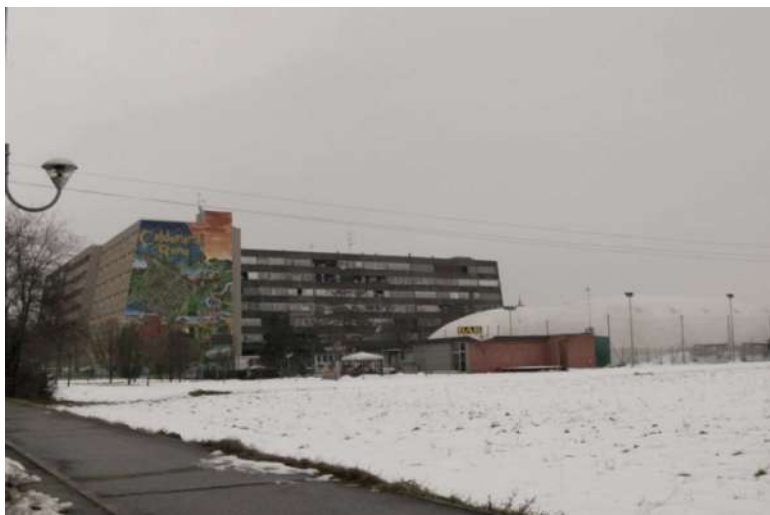
Fig. 2 – Vista del complesso Garibaldi 2 prima delle opere di demolizione. Fonte: Associazione Architetti di Strada.
