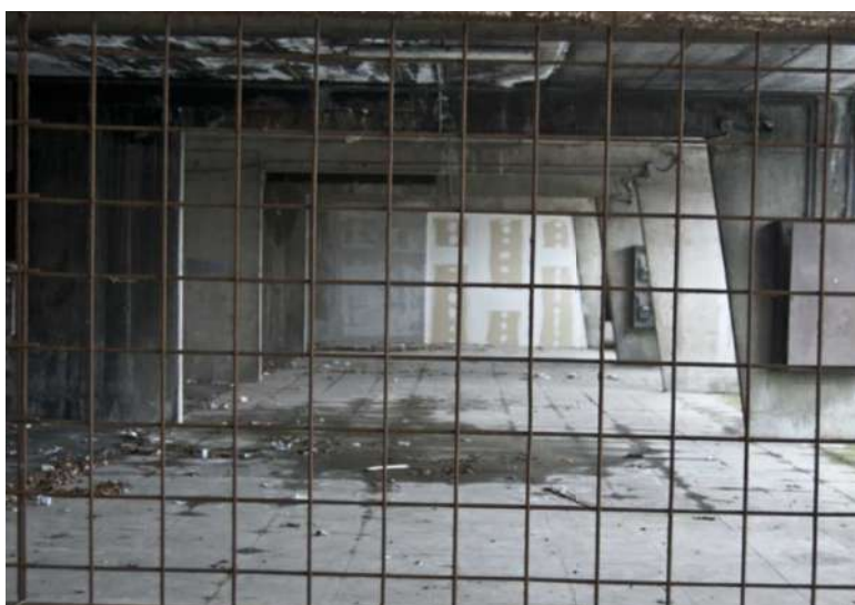
Fig. 3 – Vista del piano terra porticato prima della riqualificazione. Fonte: Associazione Architetti di Strada.
