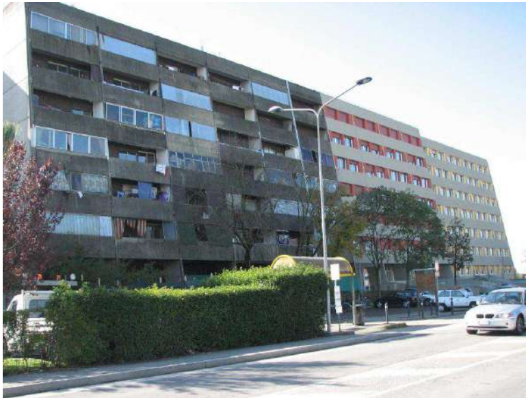
Fig. 9 – Vista dei blocchi 1 e 2 riqualificati. Fonte: Comune di Calderara di Reno.
