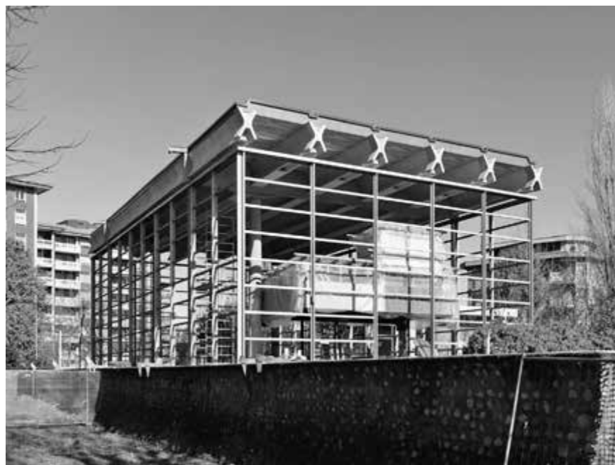
9. Cantiere di Baranzate.
