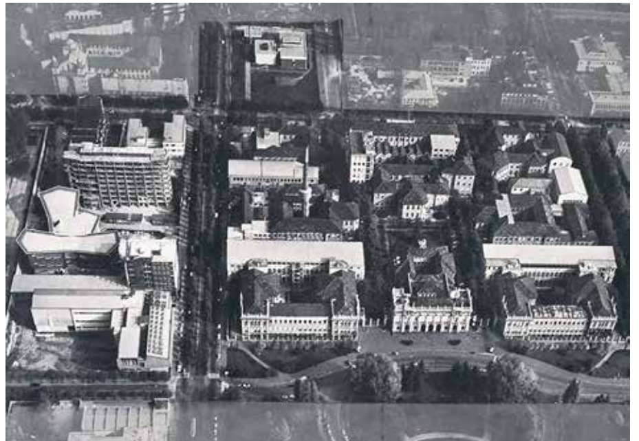
Vista aerea della sede di Architettura e, in costruzione, il Trifoglio e la Nave, anni Sessanta (Archivi storici, Politecnico di Milano.)
