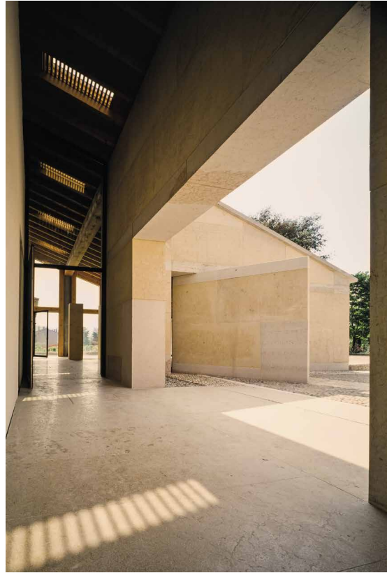
Fig. 2 Cantina Gorgo. La corte della Cantina Gorgo a Custoza costruita in pietra montata a secco.
