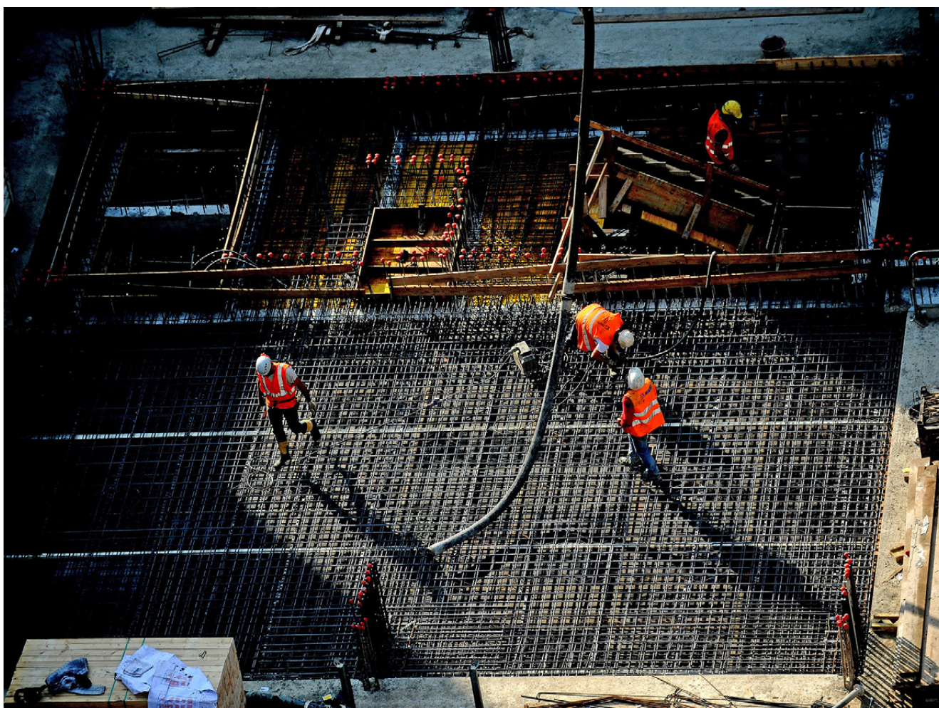
Fase di armatura di un solaio in c.a. dei livelli interrati
