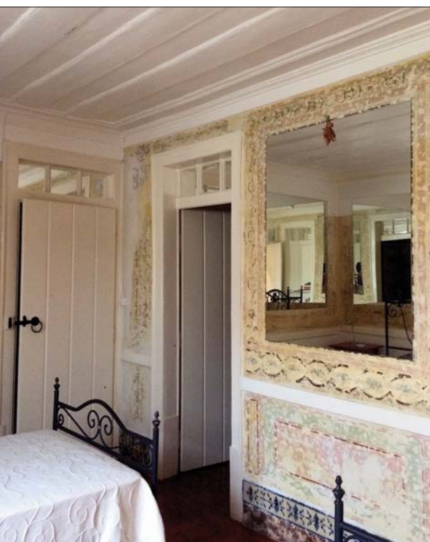
FIGS. 3 E 4 – À esquerda, tectos de saia-camisa, pintura decorativas e rodapés em azulejo de padrão num 5.º andar da Rua dos Douradores.
