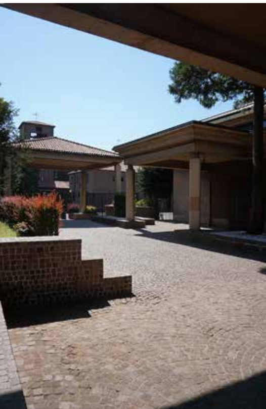
1.3 Monza, chiesa di San Biagio, 1965-1968, vista sul portico d'accesso all'aula della chiesa. (foto dell'autrice)
