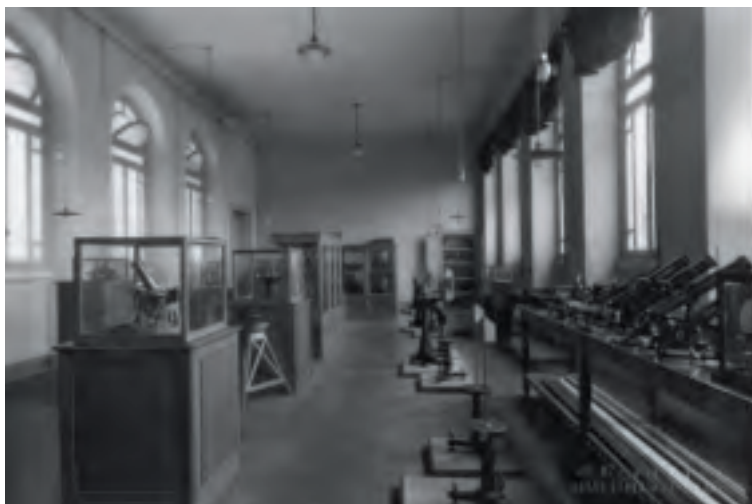
Galleria degli strumenti geodetici e topografici, 1927-1933, Archivio Storico di Ateneo, serie Miscellanea disegni, dediche, fotografie , in Archivi Storici Politecnico di Milano
