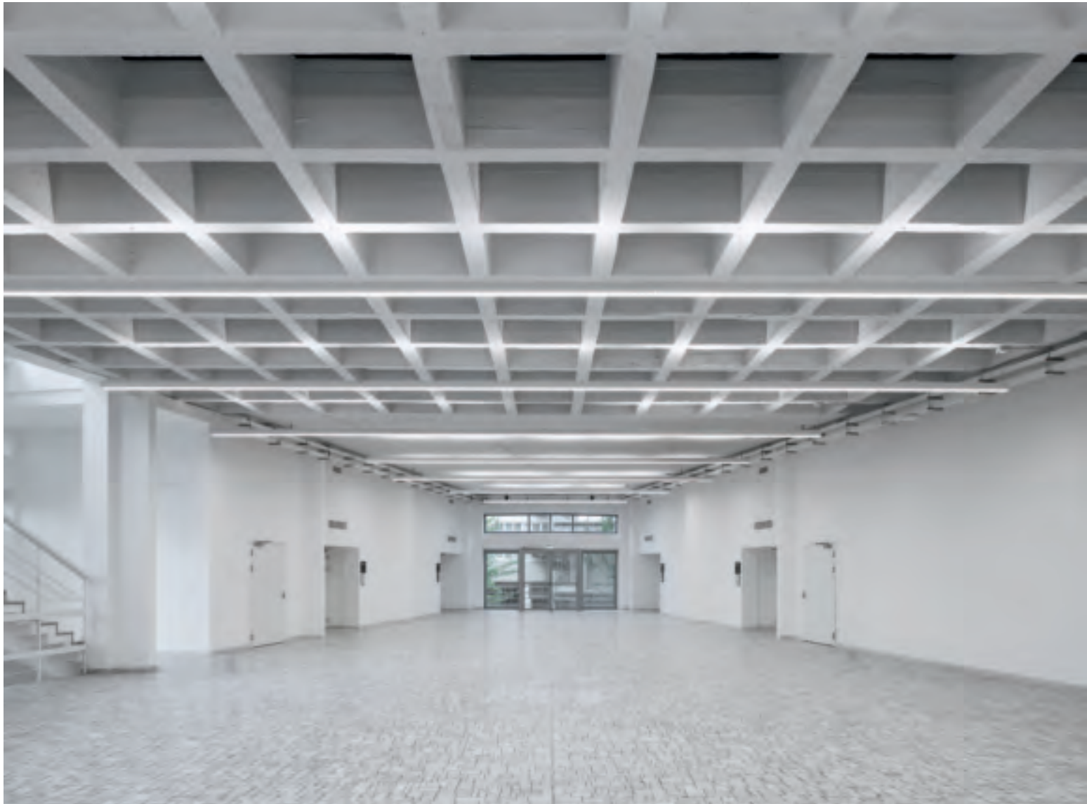
L'atrio, collocato al primo piano, dell'edificio Trifoglio con la grande copertura a cassettoni in cemento armato rinvenuta e valorizzata
