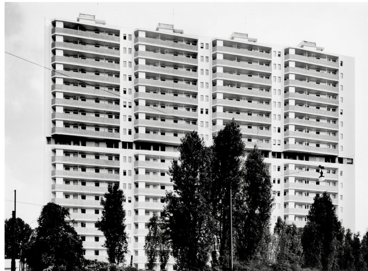
La facciata su via Ferruccio The front facing via Ferruccio
