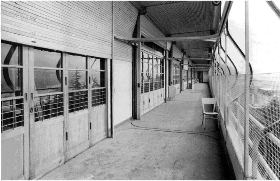
Figura 15 - Verande di cura al Villaggio Sanatoriale di Sondalo. In evidenza il sistema di guide metalliche per il movimento dei serramenti (S. ROSSATTINI, op. cit. , p. 47)
