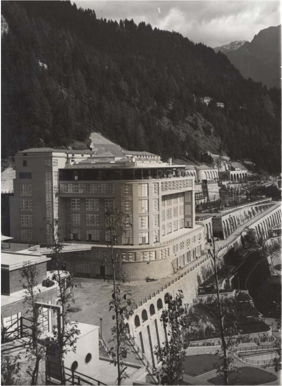
Figura 29 – Fronte del VII padiglione (Insml, Fondo Cln della Lombardia, serie n. 19: Cantieri edili ed edifici costruiti: 1933-1940, doc. n. 8)
