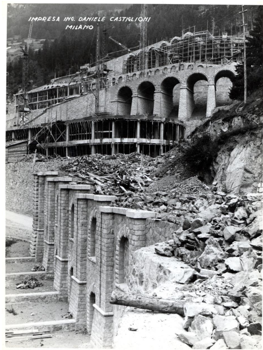
Figura 33 – Il cantiere del Villaggio Saantoriale di Sondalo, anni Trenta. In primo piano le opere di contromurazione, e le strutture del padiglione chirurgico (Insml, Fondo Cln della Lombardia, serie n. 6: Documentazione fotografica su edifici costruiti dall'impresa ingegnere Daniele Castiglioni, Roma e Milano, 1938-1940, doc. n. 11)
