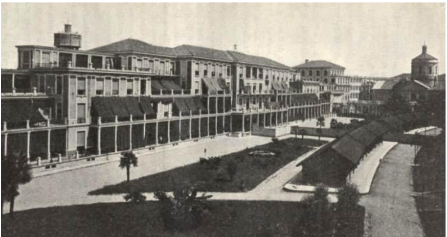
Figura 3 – Scorcio dell'edificio e della veranda in legno del Sanatorio "Vittorio Emanuele III" a Garbagnate Milanese. (F. STROPPIA, L'ospedale-sanatorio Vittorio Emanuele III del comune di Milano in Garbagnate milanese , Tip. Stucchi Ceretti, Milano, 1928, p. 7)
