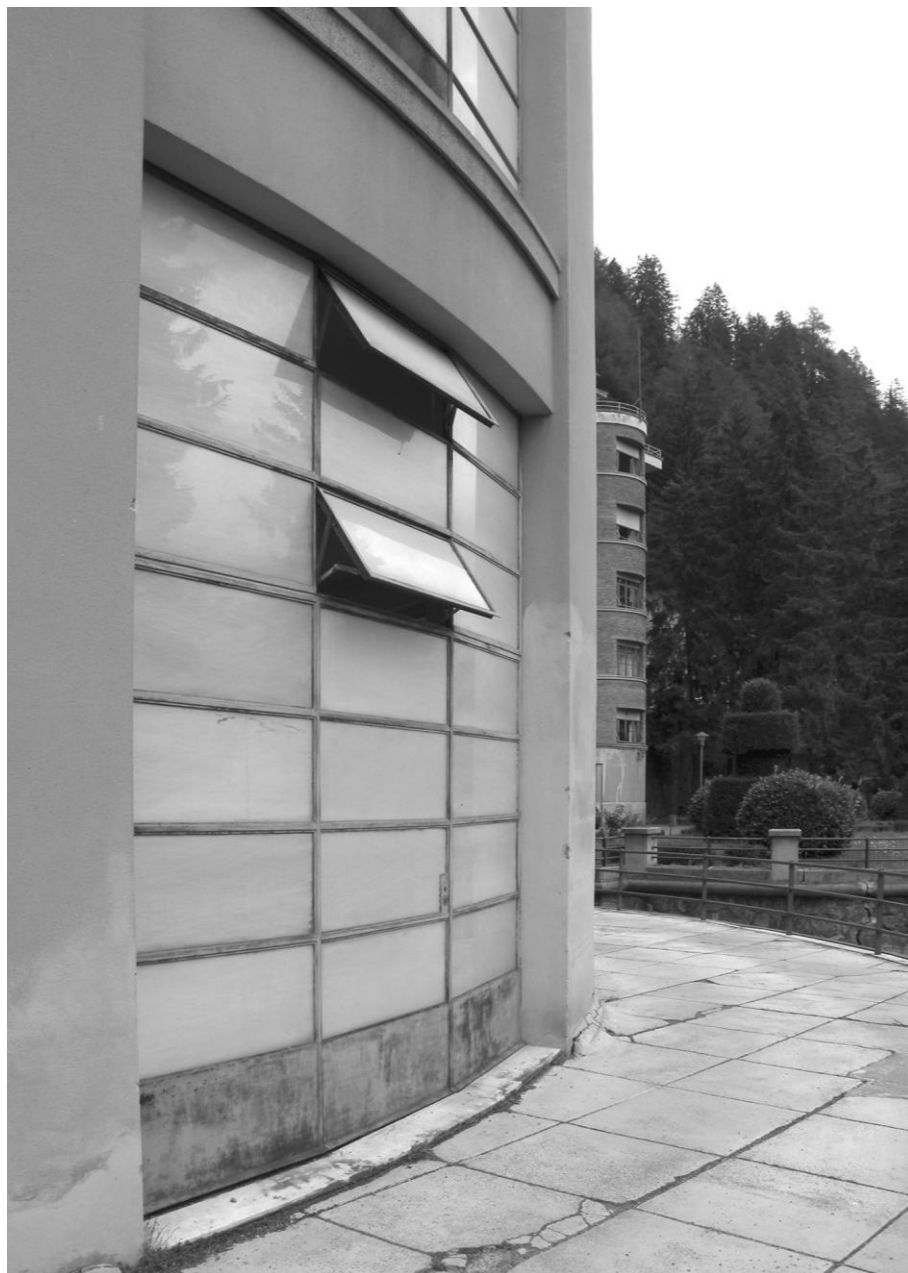
Figura 30 – Padiglione dei servizi, particolare della soluzione d'angolo (foto dell'autore)
