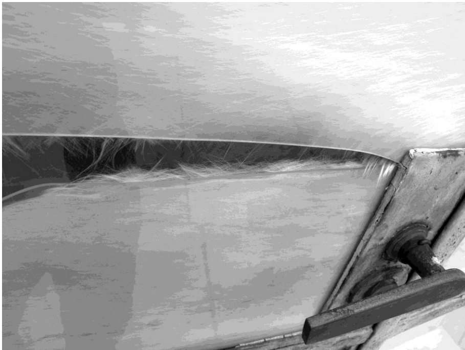
Figura 31 - Padiglione dei servizi, dettaglio dei tamponamenti vetrati termolusc, a doppia lastra con isolante interposto (foto dell'autore)
