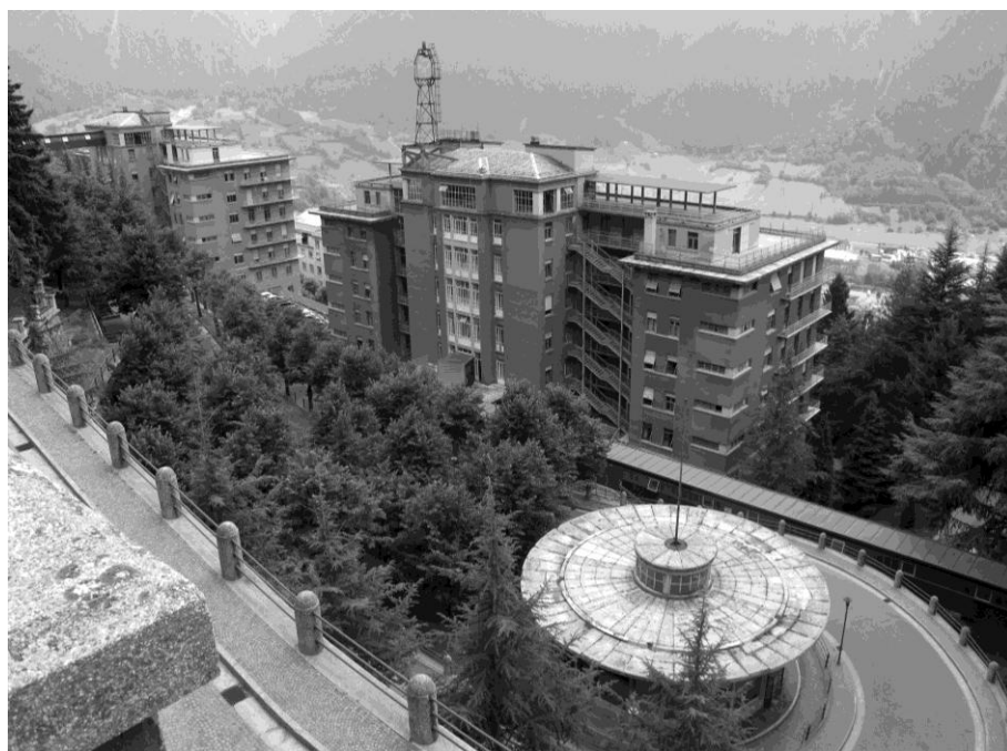
Figura 27 – v e vi padiglione, tornante stradale con chiosco circolare (foto dell'autore): schemi tipologici adattati alle particolarità del sito o messa a punto di soluzioni su misura in un disegno complessivo in formazione?
