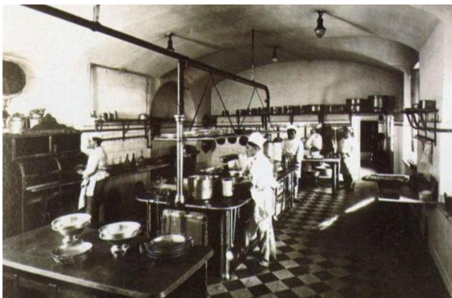
Figura 13 – La cucina del sanatorio “Pineta di Sortenna” (Archivio Storico Istituto Sorelle della Misericordia di Sondalo)
