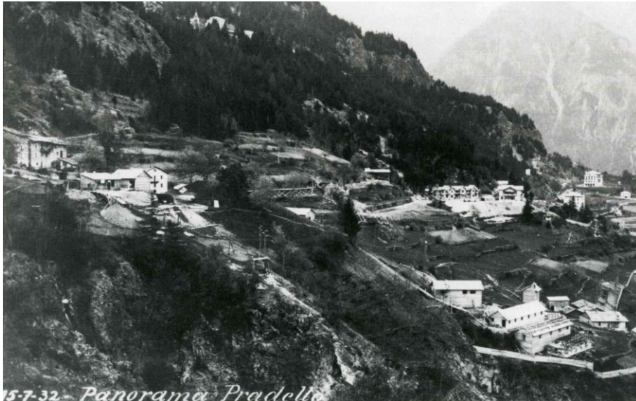
Figura 22 – Allestimento del cantiere del Villaggio Sanatoriale di Sondalo, luglio 1932. Sulla destra si vede il padiglione in eternit per la direzione lavori (S. ROSSATTINI, op. cit. , p. 100)
