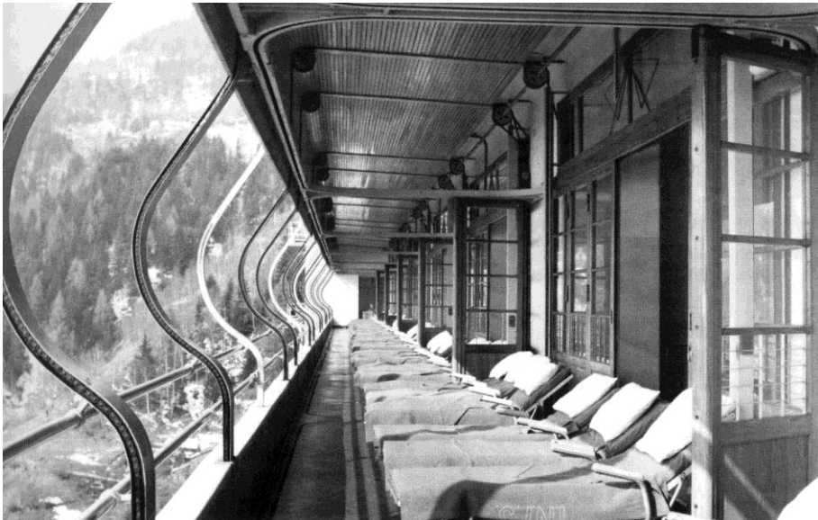
Figura 16 - Verande di cura al Villaggio Sanatoriale di Sondalo con le sdraio in posizione, le finestre semi aperte e le persiane avvolte (S. ROSSATTINI, op. cit. , p. 47)
