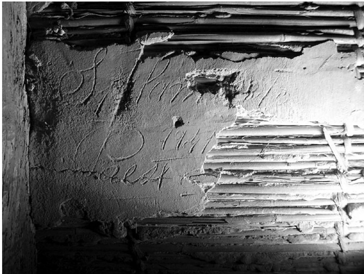
Dall'alto: Fig. 2 – Distribuzione del gradiente termico lungo la sezione BB in presenza della volta (stanza 214) e dove questa è crollata (stanza 306) Fig. 3 – Estradosso di una volta 'in camorcanna', dettaglio
