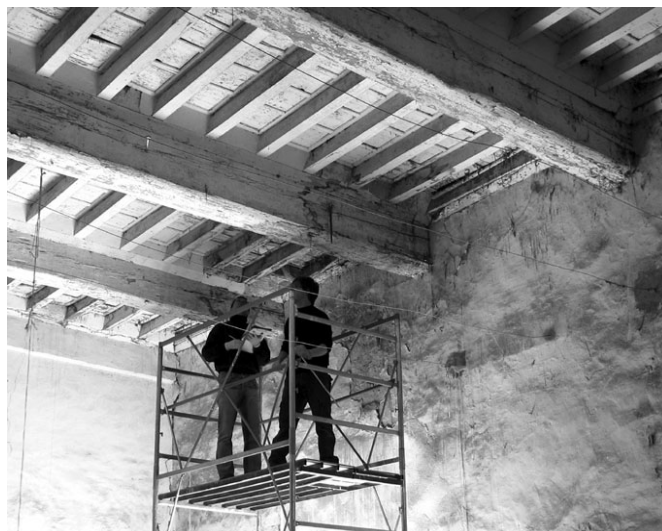
Fig. 5 – Ispezione del solaio 210
