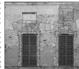
131-132. Mappatura delle unità stratigrafiche sulla facciata di palazzo Magio Grasselli: tavola generale e dettaglio intorno alla XII e XIII finestra del piano nobile.
