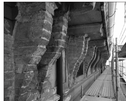
128. Le semivolute della cornice sono state formate con 15 corsi di mattoni. Una coppia di mattoni posati di coltello sopra l'ottavo corso conferisce resistenza alla sezione, compensando gli sforzi di momento e di taglio nel punto in cui questi sono massimi. Questo accorgimento è presente nelle prime quindici semivolute dal limite est della facciata, manca nelle restanti verso ovest.
