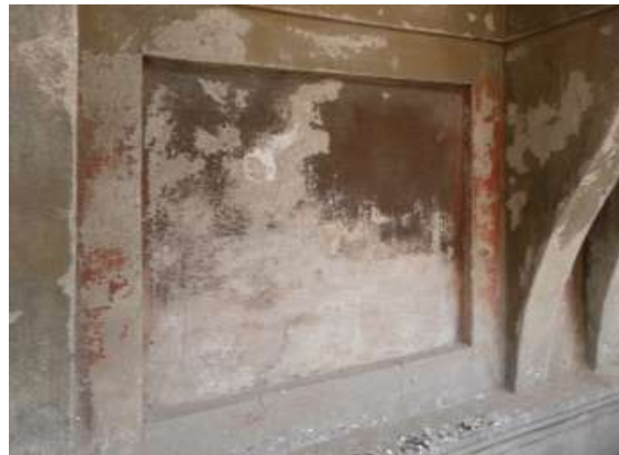
FIGURA D-E. Nella cornice la tinta rossa ottocentesca è impiegata in graduata alternanza con i resti della secentesca tinta ocra: la prima sale a rivestire le sole spalle delle finestrelle, introducendo un limite cromatico orizzontale che attenua la percezione dell'elemento architettonico (la finta finestra) in favore dell'architrave ionico. Su questo sopravvive la tinta giallo ocra che ricopre anche le sottomensole, alternandosi con il rosso ed esaltando il chiaroscuro e la plasticità della cornice. La tinta rossa riprende sopra il coronamento dell'architrave dove rivestiva sia le mensole in pietra di Sarnico, proteggendole e mascherandole ad un tempo, sia l'intradosso delle lastre di beola, nello spessore di un sottile intonachino.
