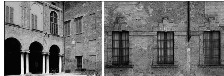
136. Nel tratto mediano del prospetto, una soluzione di continuità orizzontale distingue la muratura in laterizi e malta di calce con cornici in fase del piano terra dalla soprastante muratura di laterizi e malta di bazzana che forma il piano nobile e la cornice. La medesima discontinuità si riscontra anche sui due prospetti interni, a suggerire una scelta costruttiva intenzionale, una successione di fasi costruttive o lotti nell'ambito del lungo cantiere secentesco.
