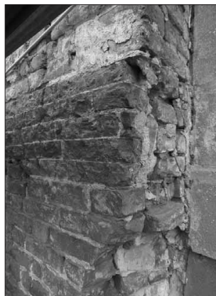
129. Traccia di una fascia aggettante, in fase con la muratura M1. Prima di stendere l'intonaco, al termine dei lavori secenteschi, i laterizi sporgenti sono stati ridotti al piano della facciata.
