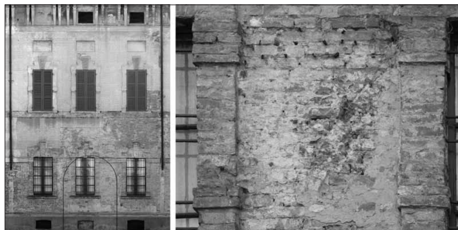
133. Dieci mattoni posati di testa descrivono l'imposta di un arco a tutto sesto, tra la terza e la quarta finestra del piano terra. Prolungando l'arco descritto dai mattoni si ottiene la sagoma di un fornice largo poco meno di metri 3,80 e alto in chiave metri 5,30, pari a circa 7 x 11 braccia cremonesi, corrispondente al bocchirale della casa appartenuta a Ferrante Magio.
