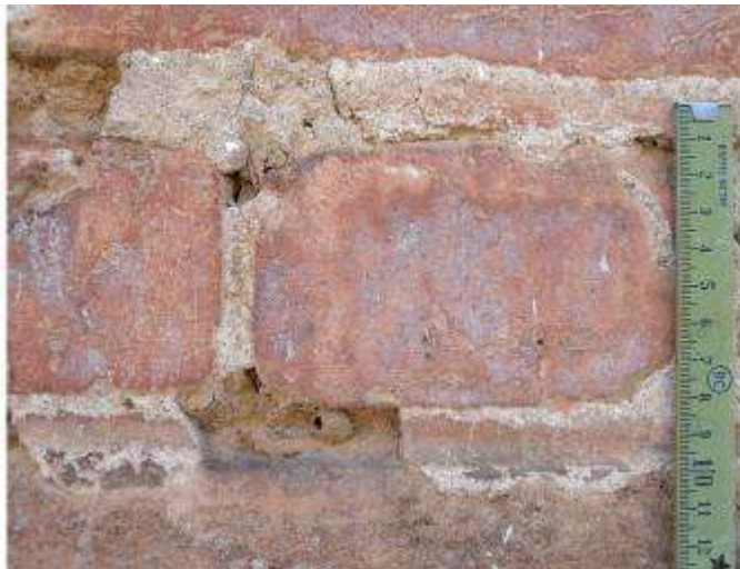
FIGURA A. Estensione e carattere della muratura M1 con giunto in malta di argilla, coprigiunto sagomato e trattamento protettivo che riveste sia la superficie del mattone sia quella del coprigiunto.
