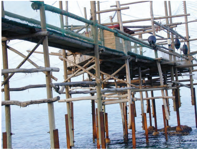
Foto 12 struttura portante del trabucco ricostruito a Rocca San Giovanni (CH)
