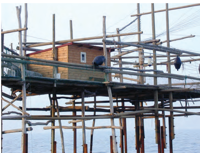
Foto 8 trabucco ricostruito in Abruzzo, la struttura è molto più solida e stabile
