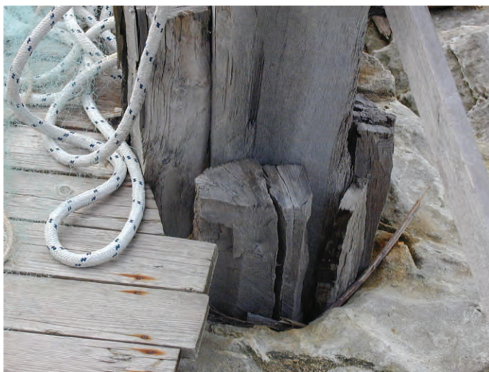
Figura 88 Trabucco a Peschici (FG) Uso delle zeppe
