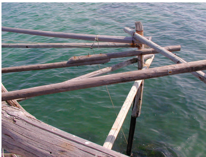
Foto 6 reticolo che irrigidisce lateralmente la struttura
