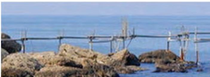
Foto 22 passerella del trabucco di Cala San Nicola a Vasto da una foto storica
