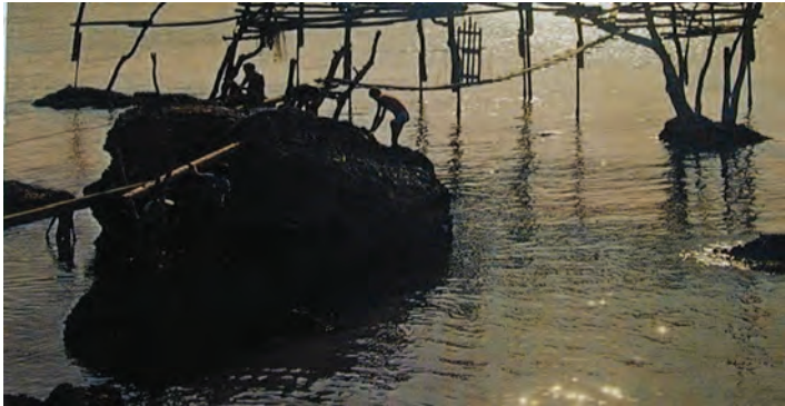
Foto 19 passerella del trabucco del Trave a Vasto da un'immagine storica
