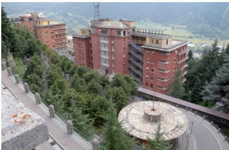
Fig. 13. Vista dall'alto del V e del VI padiglione, con la soluzione del chiosco circolare all'interno del tornante (Foto DDC): definizione costruttiva di tipologie importate alle particolarità del sito o messa a punto di soluzioni su misura in un disegno complessivo in evoluzione?
