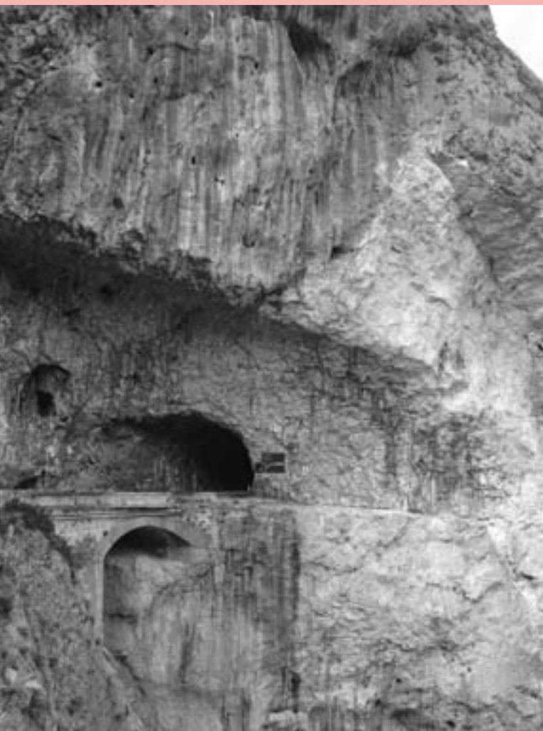
Francesca Guerrucci, Galleria scavata nella roccia della strada regionale 479 Sannite (SR 479) nel tratto che attraversa le Gole del Sagittario (AQ), 2012
