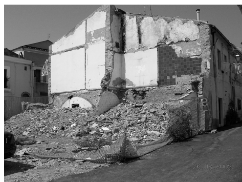
Fig. 8 Campomarino, isolato 663, demolizione.
