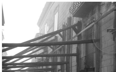
Fig. 6 Guglionesi, cedimento del puntello.
