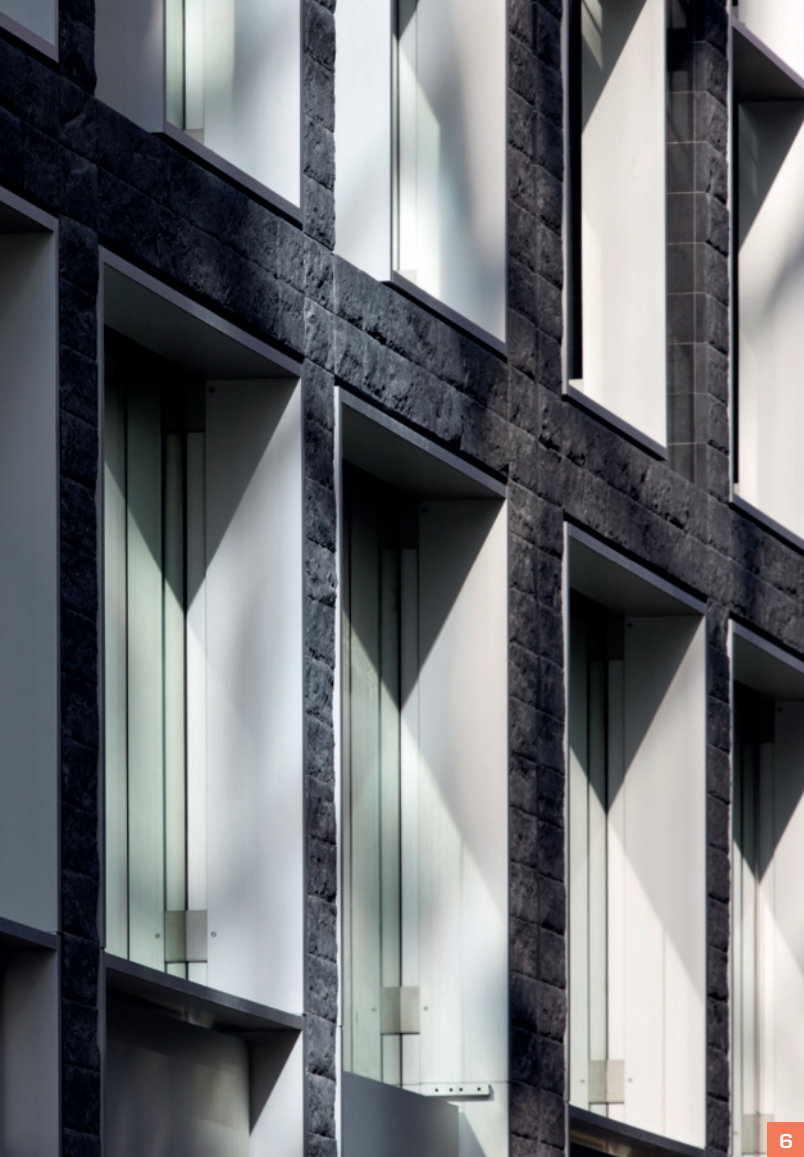
Immagine 6. Esecuzione della cortina di rivestimento lapideo secondo la tessitura delle cornici in profili di alluminio sospesi all'intelaiatura di facciata
