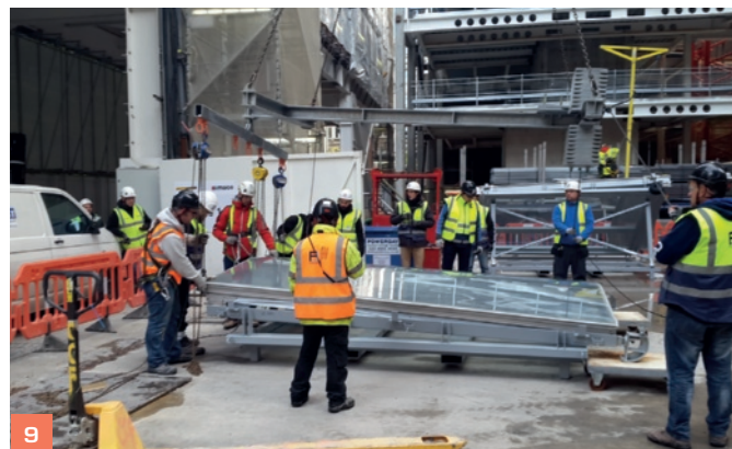
Immagine 8. Sequenza costruttiva: fase di montaggio dei componenti di facciata a cellule rispetto alle staffe predisposte al perimetro delle strutture di elevazione orizzontali.
