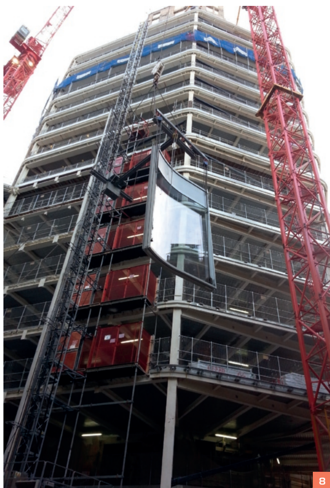
Immagine 10. Composizione del sistema di facciata relativo all'area reception, comprensivo della struttura di trattenimento della balaustra in vetro del terrazzo
