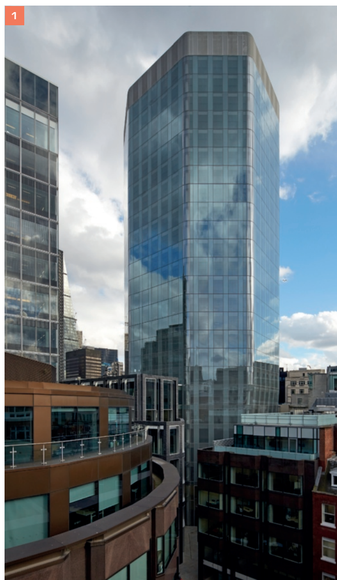
Immagine 1. Configurazione planivolumetrica e percettiva della costruzione a torre all'interno del tessuto urbano
