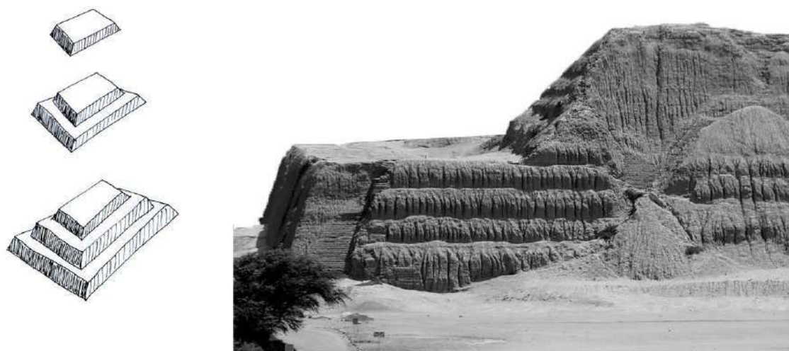
FIGURA 1. Esquema de etapas constructivas Huaca del Sol, Cultura prehispánica Moche. Fuente: Elaboración propia.
