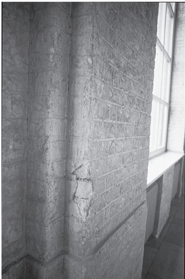
Fig. 3 - München, Alte Pinakothek, facciata Sud prima dei restauri (foto dell'autore, agosto 1977).
