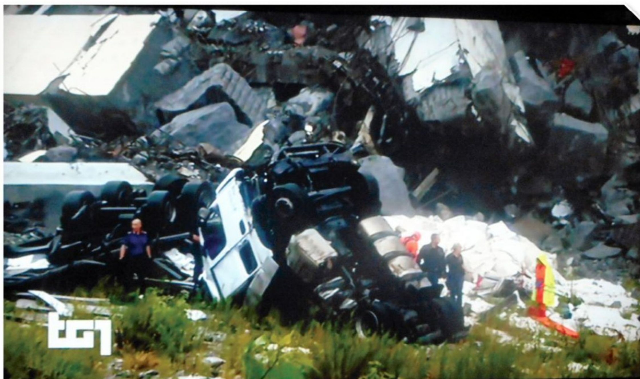
El tractor del tanque entre los escombros del puente.
