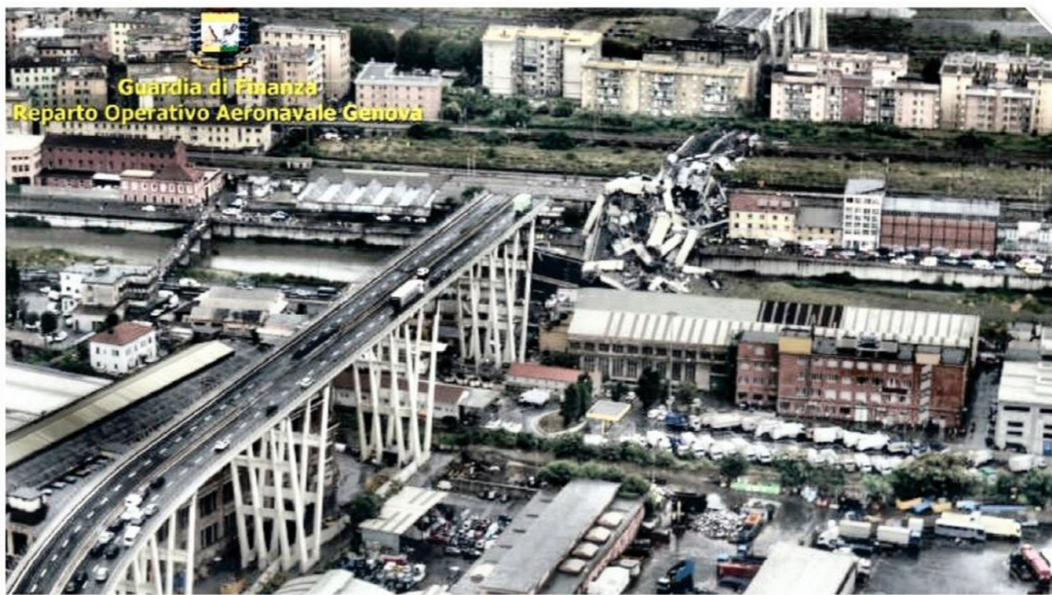
Fotografía desde el helicóptero del colapso del viaducto de Morandi en Génova.
